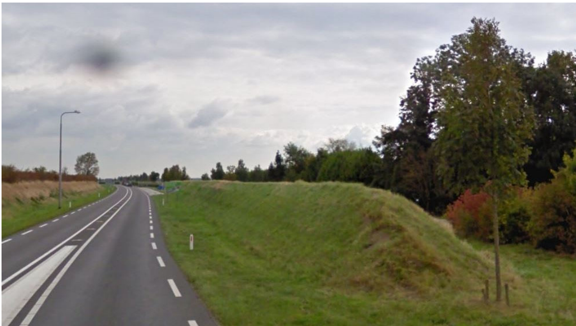
Figuur 2.3: Geluidwal langs zuidzijde provinciale weg (foto: Google).
