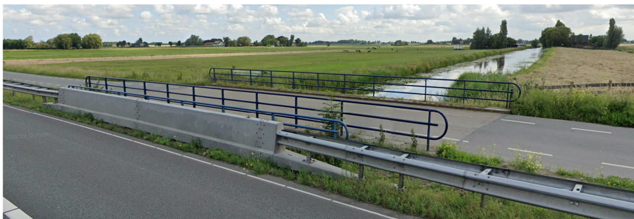
Figuur 2: Bestaande hekwerken duikerbrug Tempelweg
