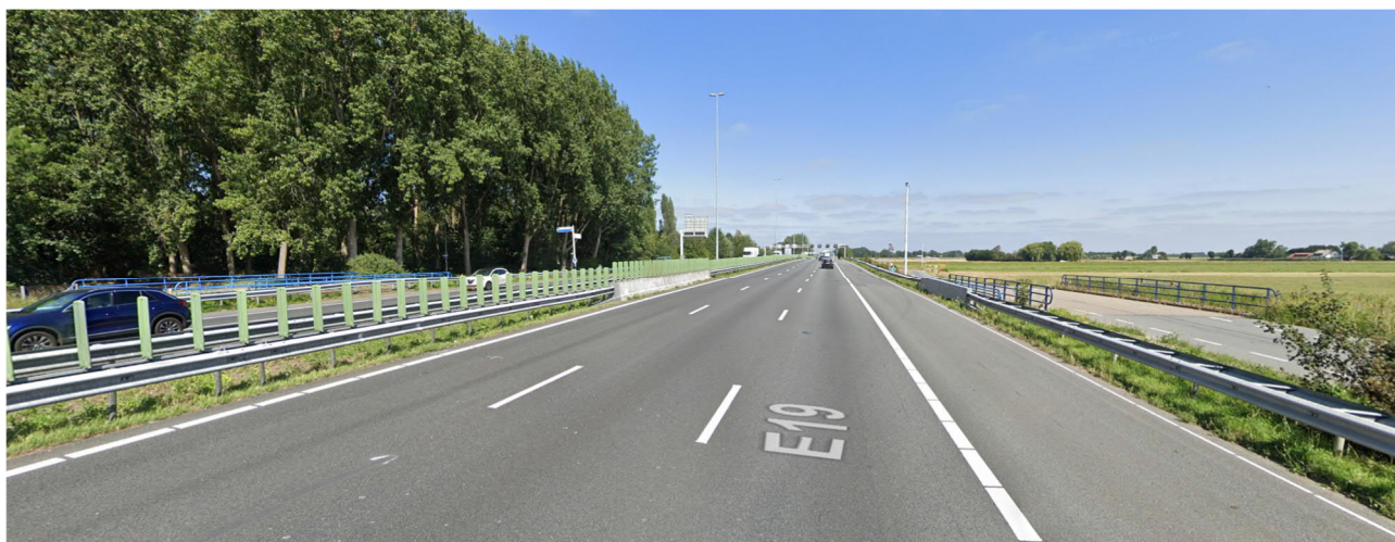
Figuur 1: Bestaande duiker t.p.v. de Tempelweg
