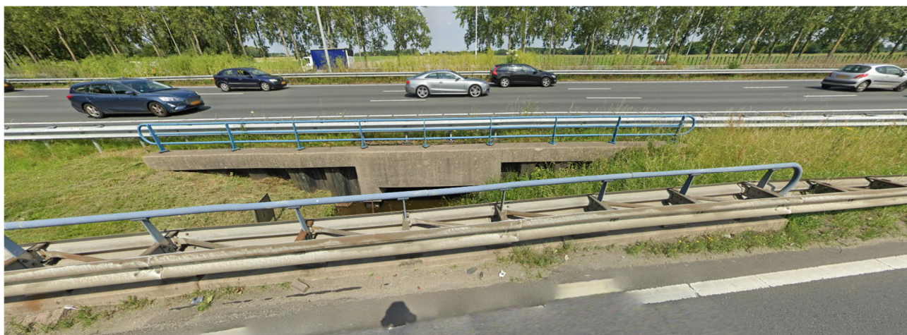
Figuur 2: Vormgeving bestaande duikers onder de A13
