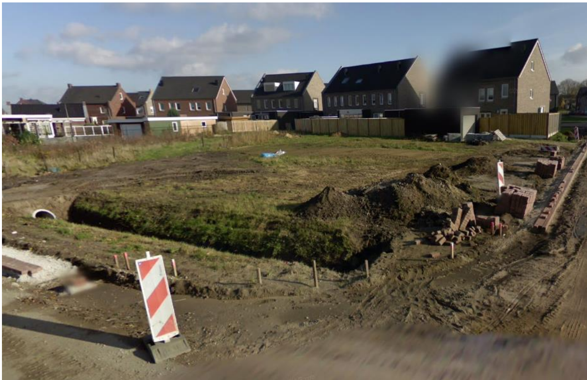
Figuur 1. Reconstructiewerkzaamheden rondom de locatie (bron: streetview)
