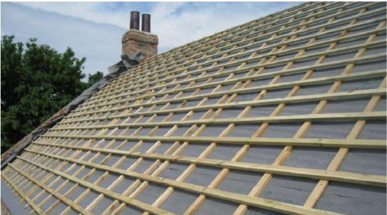
Dak met BAT Safe (vleermuisvriendelijke dampopenfolie) (Bron: Faunaprojecten.nl)
