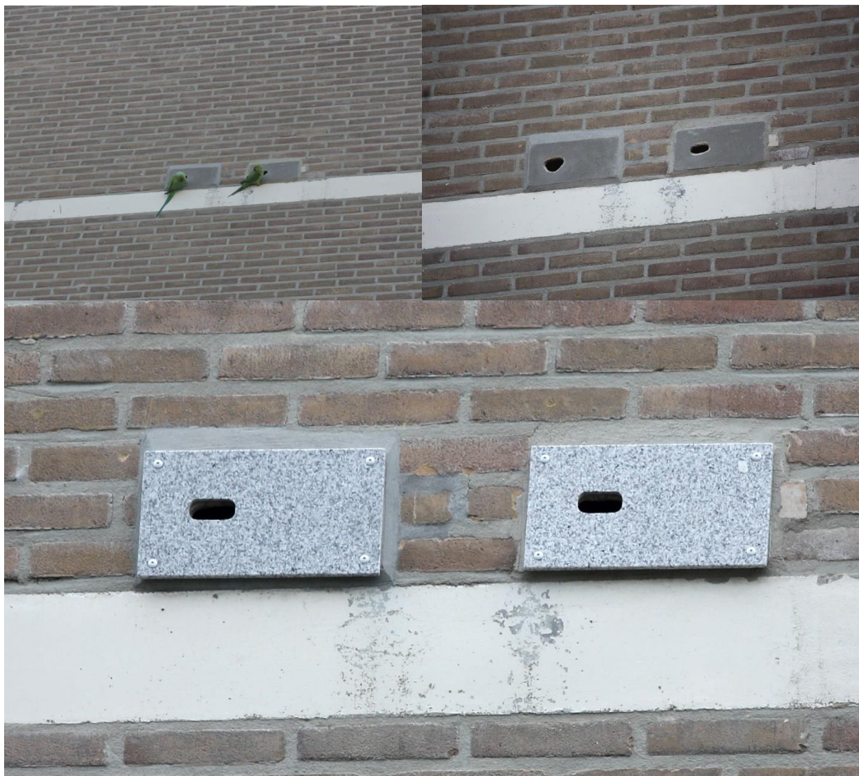
Halsbandparkieten die gierzwaluwkasten kraken, Als oplossing kan een marmerenplaat toegevoegd worden over de kasten (bron: Vivara Pro).
