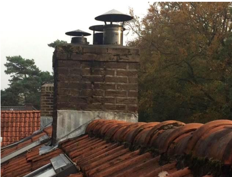
Voorbeeld schoorsteen met loodslab. Bron Werkspot.nl.
