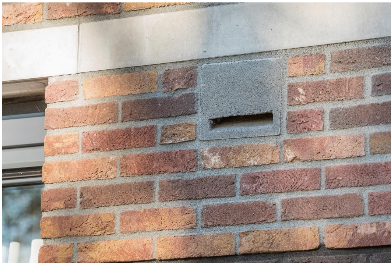
Entreesteen in een spouwmuur (Bron: Vivara Pro)
