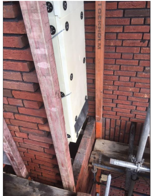
Uitvoeringsvoorbeeld project met foto's van de vleermuiskast ten behoeve van massa-winterverblijf. Platen hier zijn opgeruwd met tegellijm zodat vleermuizen grip kunnen krijgen. Bron: Arcadis.
