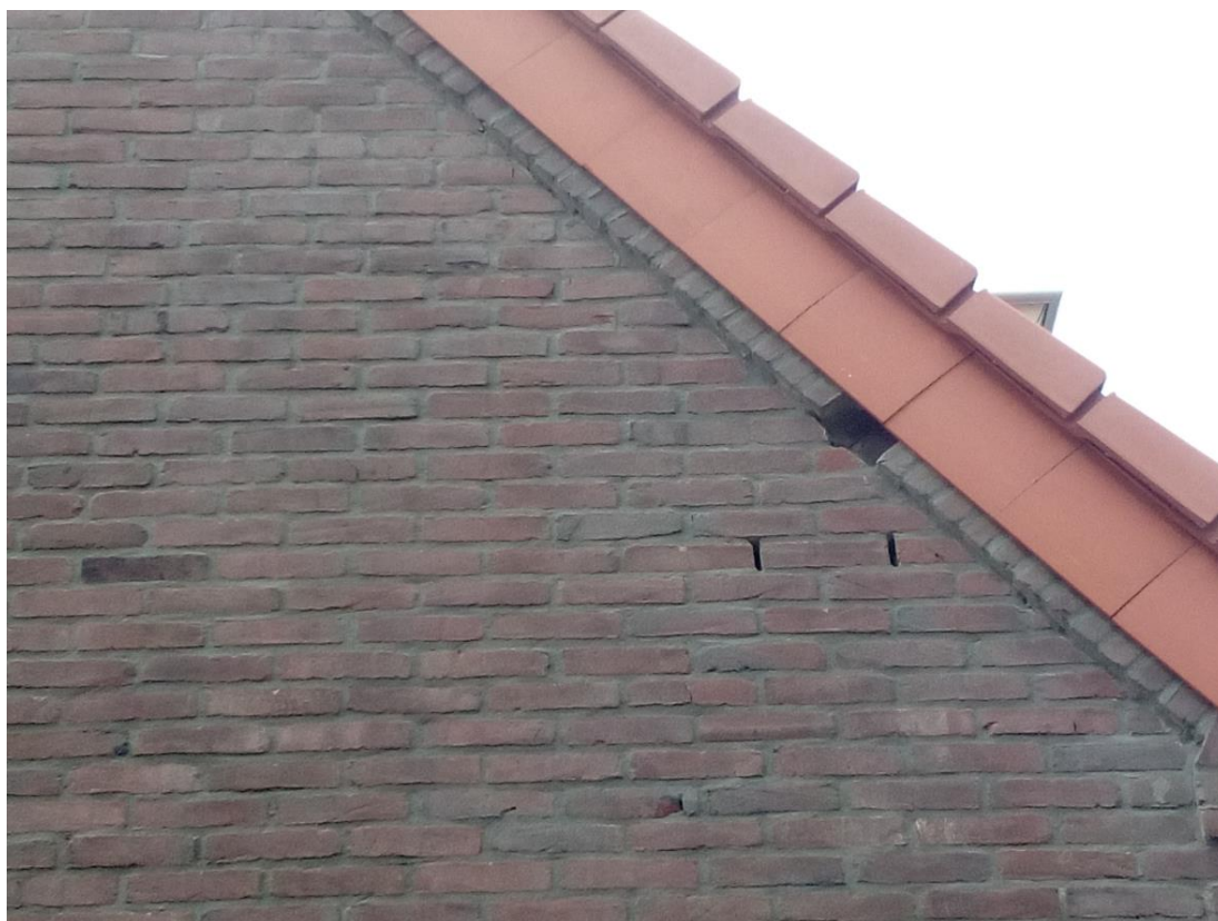
Voorbeeld gierzwaluwnest onder dakpannen. In dit geval toegang via kantpan of loodslab bij schoorsteen. Project St. Joseph in Boxtel. Bron: Arcadis.
