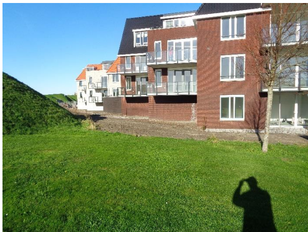
Eindsituatie (18-11-2020), zicht vanaf trafo huisje aan de zuidkant.
