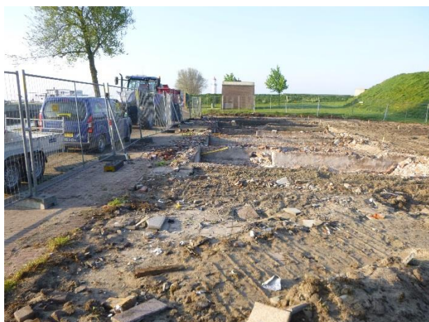
Situatie na de sloop (29-4-2019)
