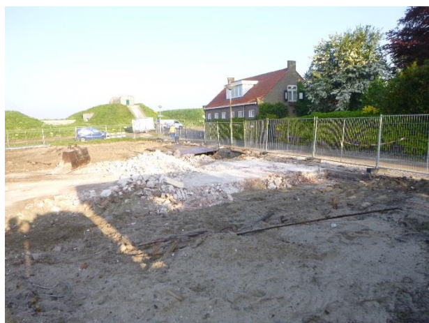
Situatie na de sloop (29-4-2019)
