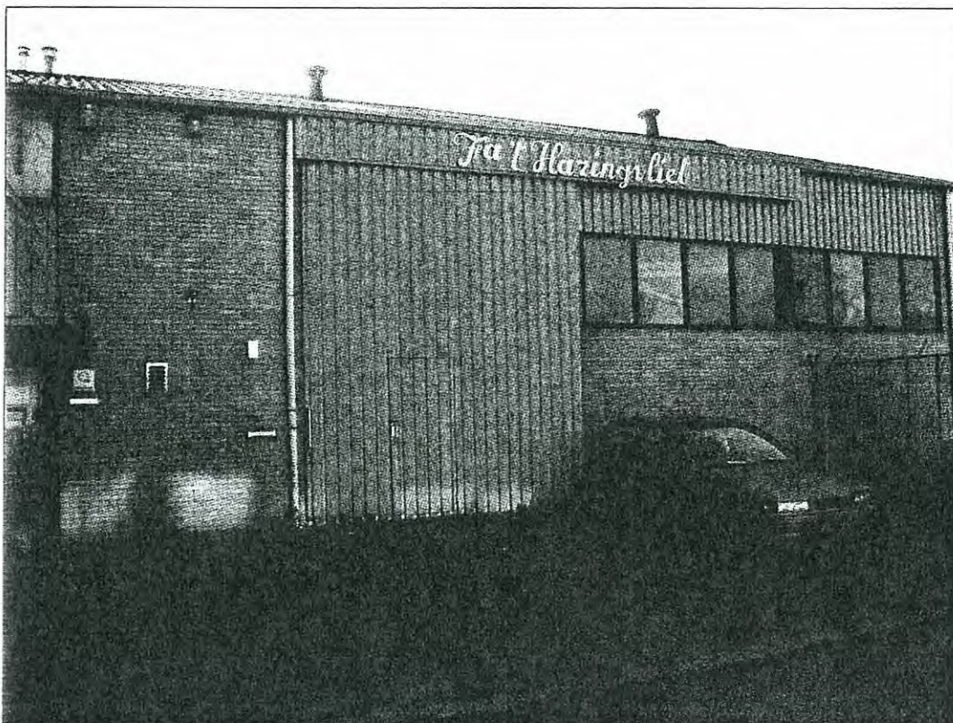
Foto 1: Molshoek 8 – Gevel bedrijfspand gezien vanaf de voorzijde
