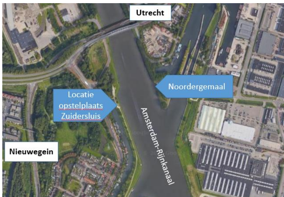
Figuur 2: locatie Noordergemaal en beoogde opstelplaats Zuidersluis te Utrecht
