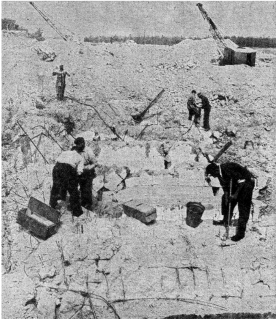
Figuur 4.10 “De slopers van Lekkerkerker hebben een complex bunkers tot puin geslagen. Hun pneumatische boren maken nieuwe gaten in het granietharde beton, waarin straks de springstoffen komen, die de bunkers aan stukken slaan.” (Het Vrije Volk, 02-07-1958)
