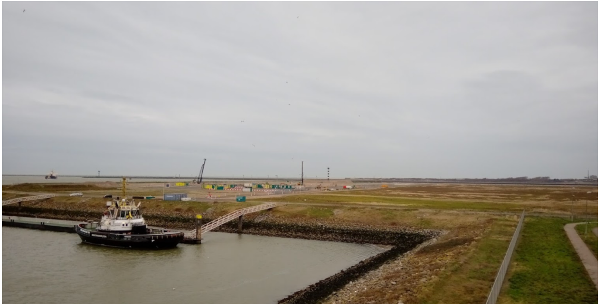
Figuur 3.2. De Kop van de Beer begin 2020 met het in aanbouw zijnde Innocent (bron: Google Maps, foto Paul Kas)
