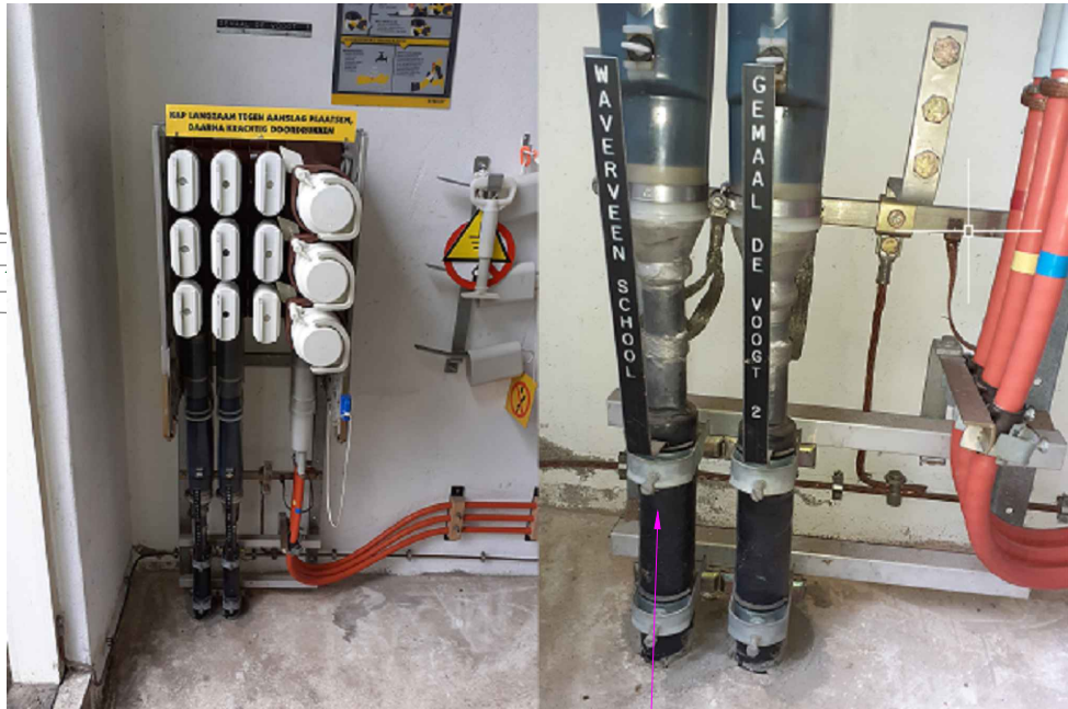
Te vervangen MS-kabel in MSR 6515 Gemaaide Voegt 1, de verbinding naar Waverveen School MSR 3986
