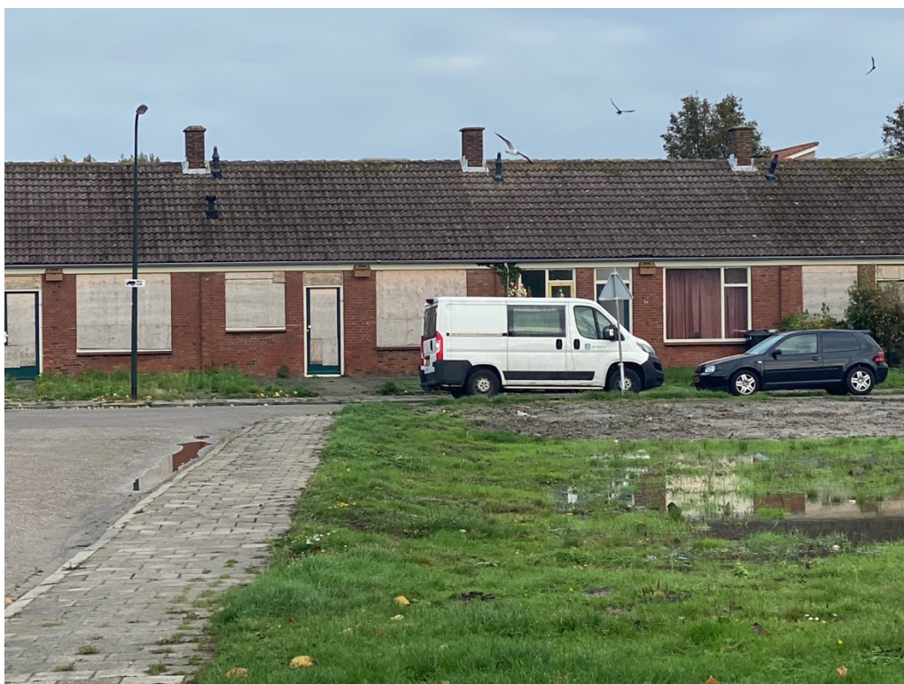
Figuur 5 De bestaande woningen aan de Frank van Borsselenstraat. Ook deze woningen zullen plaats maken voor de realisatie van de twee appartementengebouwen.
