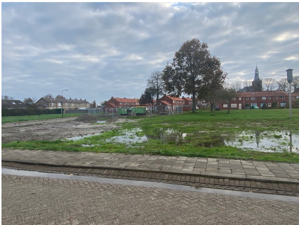
Figuur 6 Plangebied vanaf westelijke zijde (Jacoba van Beierenstraat) (zicht op het nieuwe wijkpark) Rechts zicht op de woningen aan de Cornelis Vermuydenstraat die zullen worden gesloopt om plaats te maken voor 9 nieuwe grondgebonden woningen
