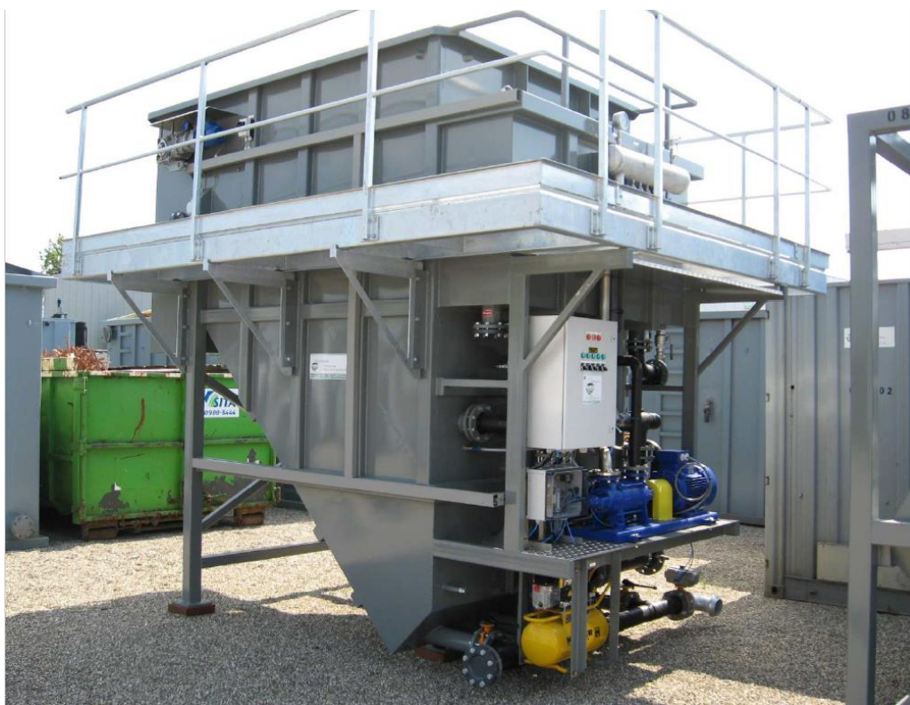
Figuur 1 Foto dissolved air flotation unit
