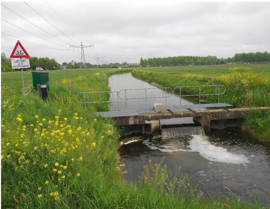
Figuur 3: Bestaande situatie Engelse aanvoersloot. Met de klok mee: foto 1; Genormaliseerd profiel Engelse aanvoersloot, foto 2; Solitaire bomen langs oever Engelse aanvoersloot, foto 3; Stuw 117MRB (reguleert het waterpeil in de Engelse aanvoersloot).
