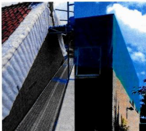
Figuur 4-2. Voorbeelden van exclusion (steiger)doeken welke voor invliegopeningen geplaatst kunnen worden om een verblijfplaats ongeschikt te maken.
