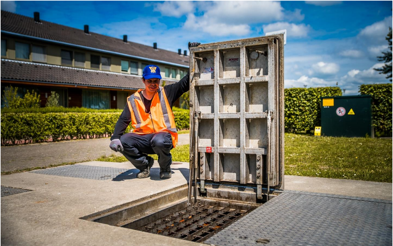
Figuur 2: Riolering Berkel en Rodenrijs (bron: Beeldbank Lansingerland)
