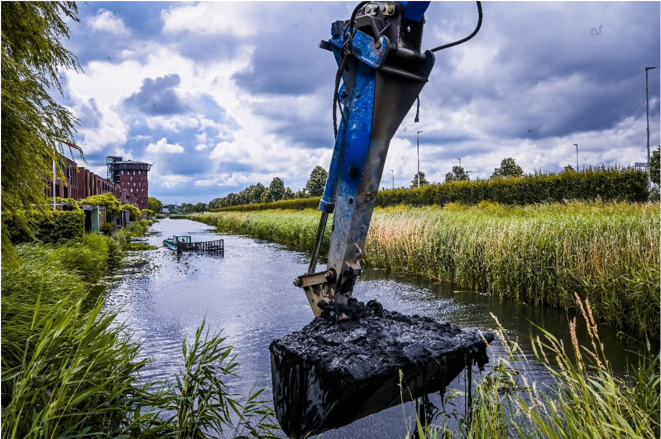
Figuur 12: Uitbaggeren (bron: Beeldbank Lansingerland)
