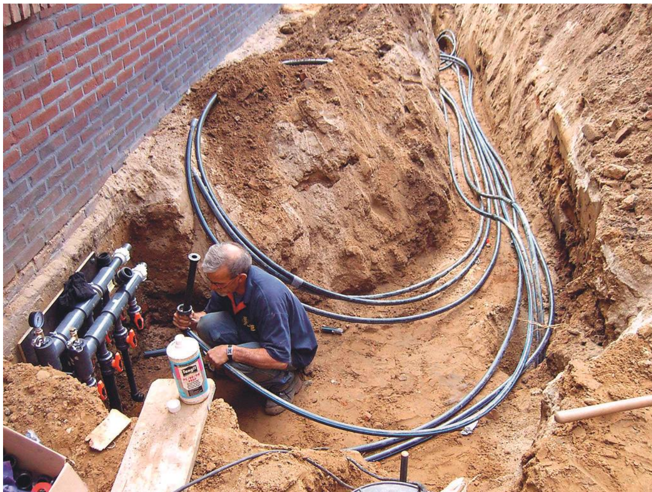
Figuur 20: Werkzaamheden aan ondergrondse infrastructuur in Lansingerland (bron: Beeldbank Lansingerland)
