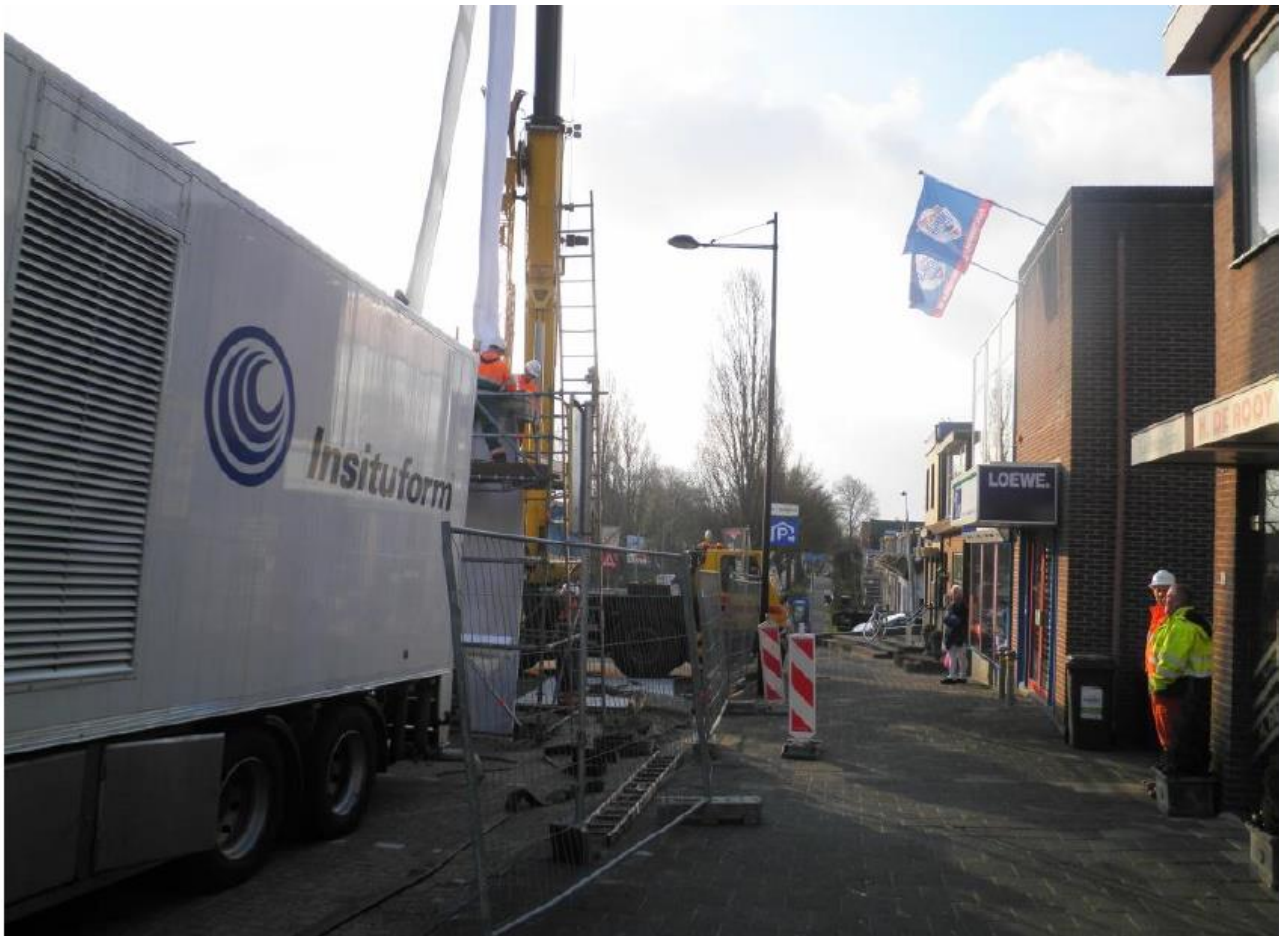
Figuur 16: Reliningswerkzaamheden Julianalaan in Bergschenhoek (bron: Jan Meerkerk)
