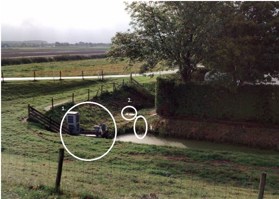
Figuur 2: Huidige locatie stuw L1 (Helledijk)(1) en stuw TUP (2). Bypass leiding met afsluiter welke wordt vervangen (3).
