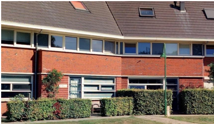
Erkers horizontaal geleded over volle breedte in Eilanden West
