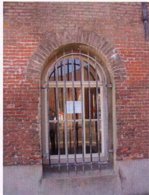
Ramen ingebracht in 1868 op een plek waar een 18 e eeuwse toegang heeft gezeten waarvan de rondboog en hardstenen aanzetstenen nog zichtbaar zijn. Links Achter de Lange Stallen en rechts de Keizerstraat. Boven het raam in de Keizerstraatgevel zijn de sporen zichtbaar van het 18 e eeuwse dakluik.
