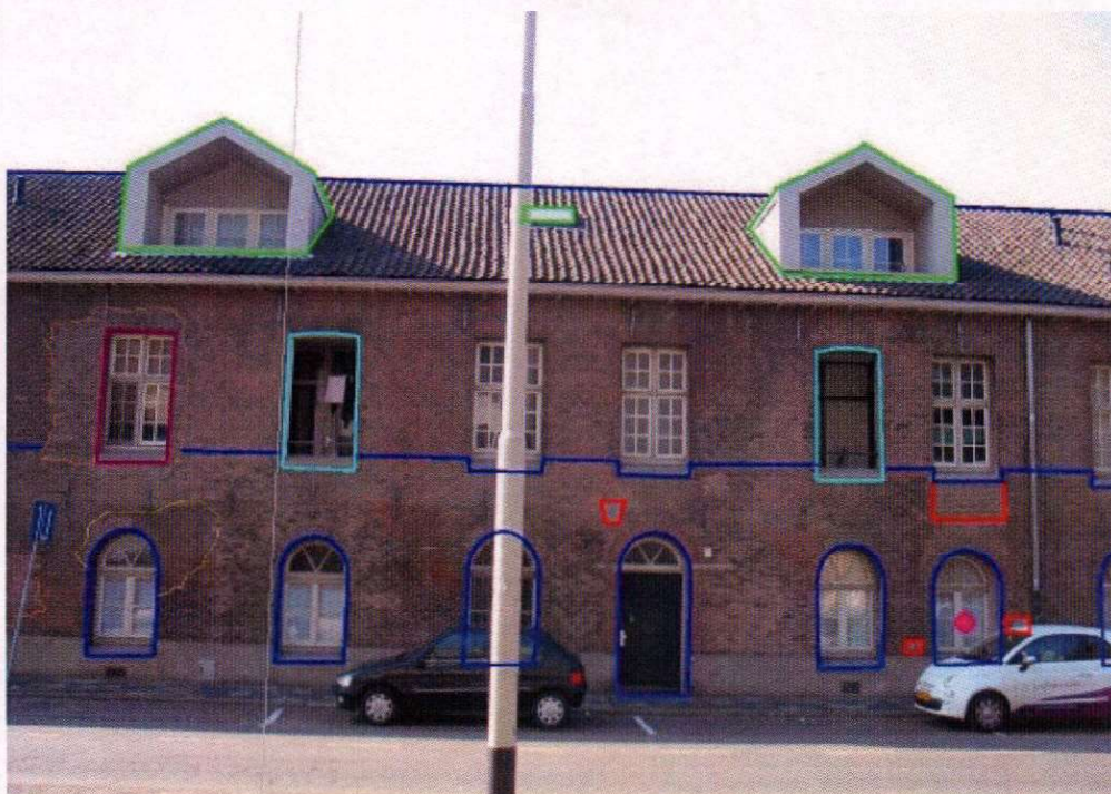
Keizerstraat (7) Centraal in de gevel zit de herplaatste jaartalsteen. Bij het raam rechts zitten hardstenen onderdelen van een 18 e eeuwse ingang. Er boven zit een spoor van dakluik voor de hooizolder
