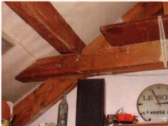
Detail kapconstructie in de meest noordelijke atelierwoning met gedeeltelijk hergebruikte balken van de 18 e eeuwse kap. Op het spantbeen en de hanebalk zitten telmerken.
