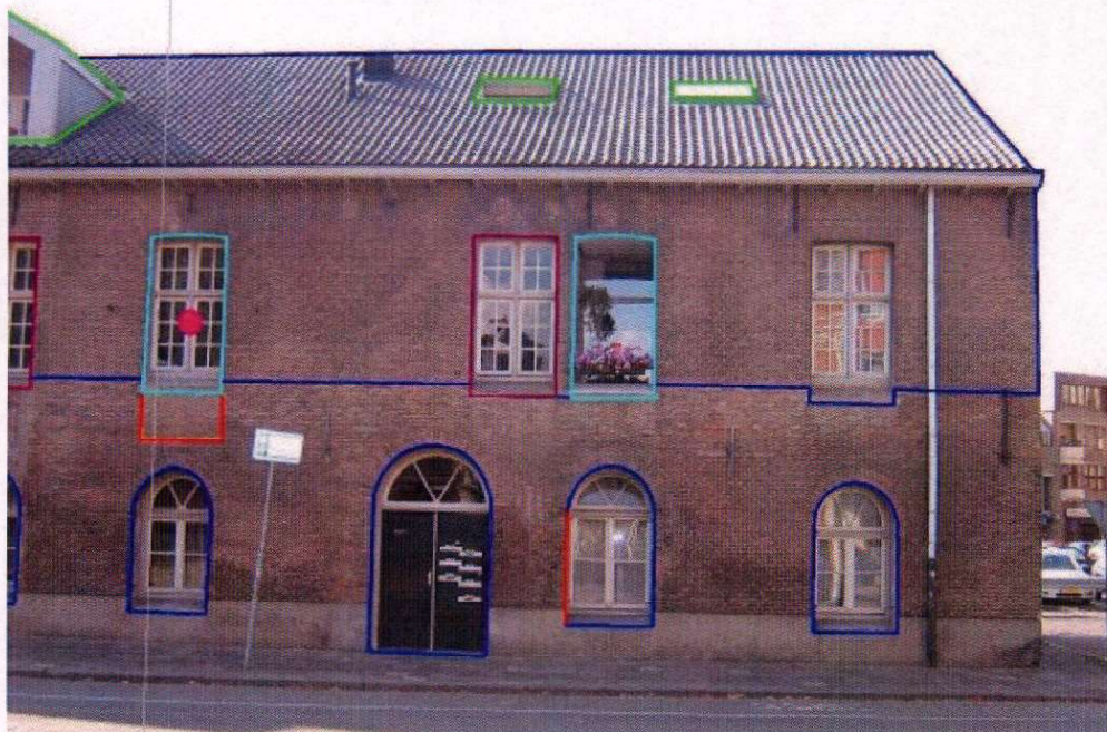
Keizerstraat (13) De voormalige deur op de verdieping voor goederen was van origine een dakluik. Eronder zat in de 18 e eeuw een ingang. De sporen hiervan zijn nagenoeg verdwenen. Het tweede raam van rechts op de begane grond heeft een 18 e eeuwse dagkant
