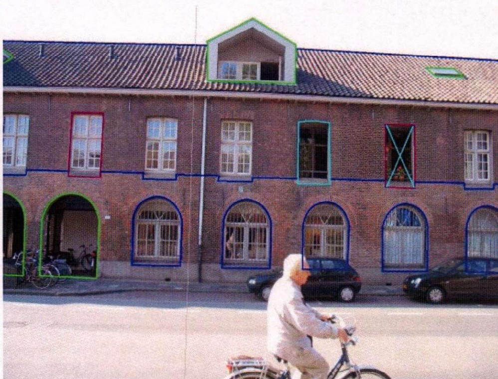
Keizerstraat (3) De omkadering van de loggia rechts geeft de fase aan wanneer er een raam is aangebracht. Het kruis geeft de periode aan wanneer de loggia is aangebracht
