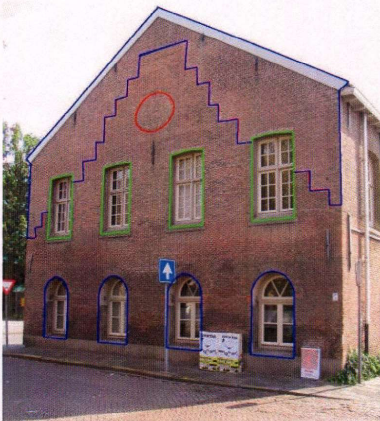
Keizerstraat (13) De voormalige deur op de verdieping voor goederen was van origine een dakluik. Eronder zat in de 18 e eeuw een ingang. De sporen hiervan zijn nagenoeg verdwenen. Het tweede raam van rechts op de begane grond heeft een 18 e eeuwse dagkant
