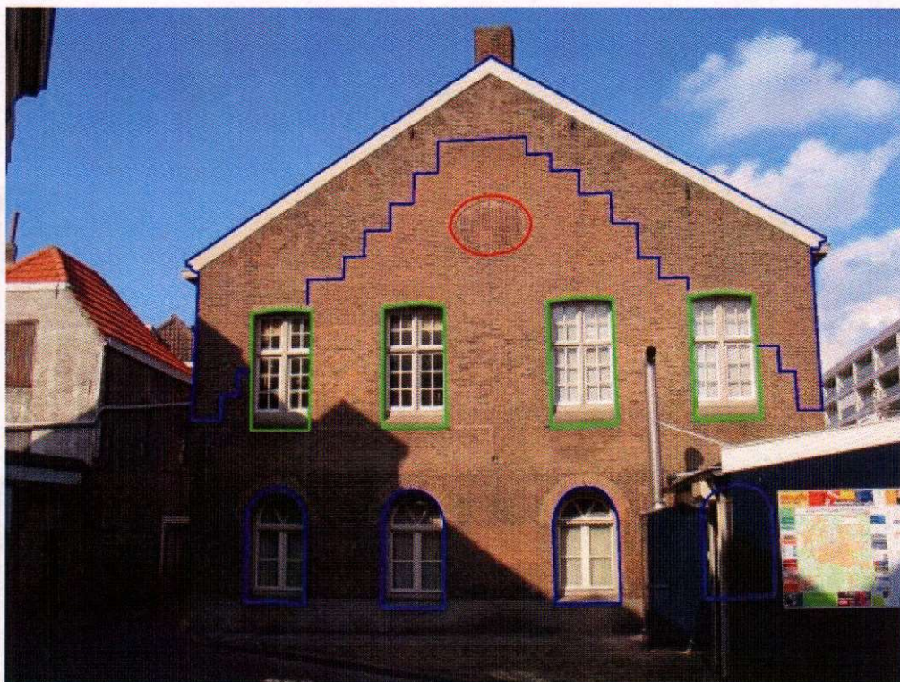
Vierwindestraat (zuidgevel) De oude daklijn van de 18 e eeuwse stallen zijn duidelijk zichtbaar. Centraal is de oude oeuf de boef zichtbaar. Er hebben drie ramen in de oude 18 e eeuwse gevel gezeten. Wanneer die zij aangebracht is onbekend. In 1947 waren deze ramen dichtgemetseld. Met het aanbrengen van de vier nieuwe ramen in 1980-81 zijn de sporen van deze ramen nauwelijks herkenbaar.
