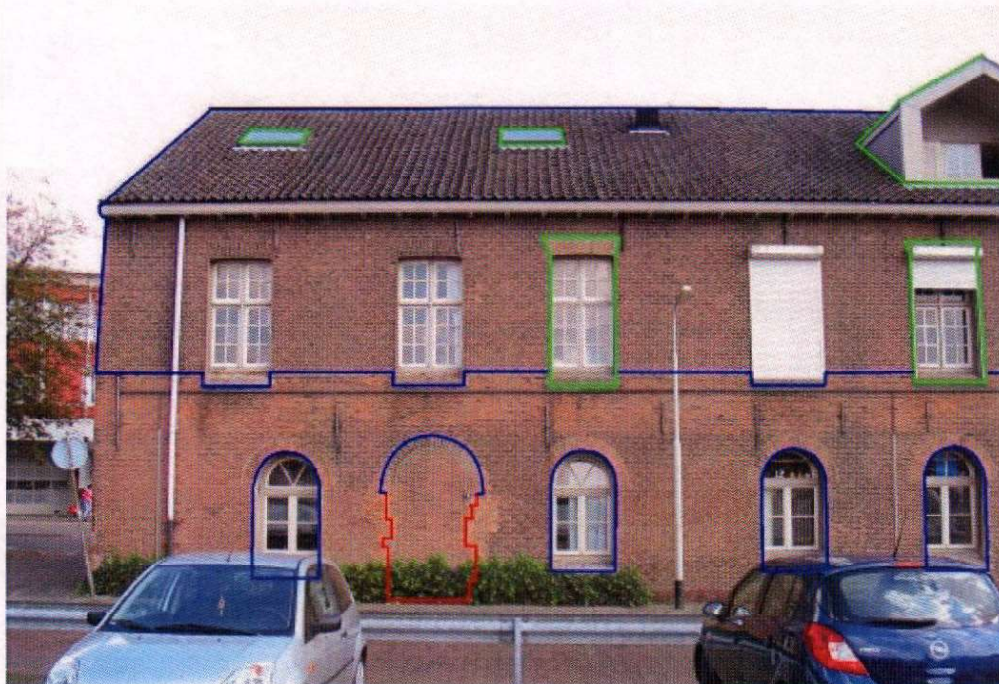
Achter de lange stallen (1) Op de begane grond zijn de sporen zichtbaar van een oorspronkelijk 18 e eeuwse doorgang met een 19 e eeuwse rondboog
