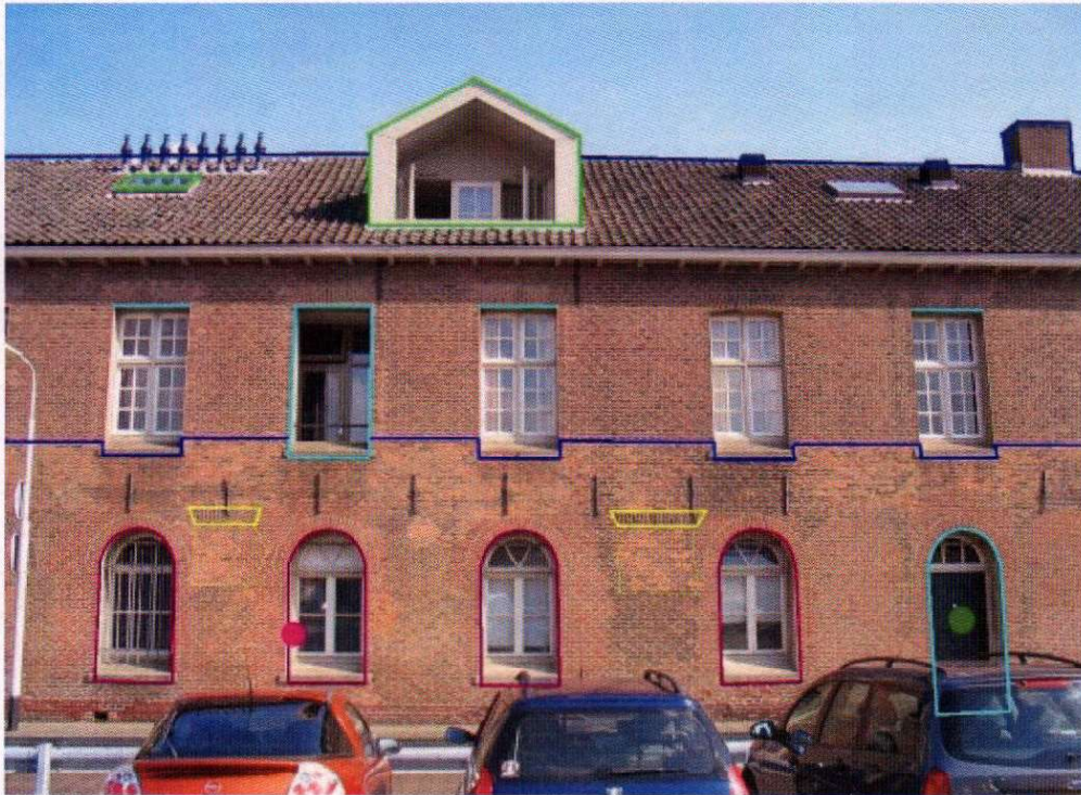
Achter de lange stallen (7) Op de begane grond zijn de sporen zichtbaar van twee vierkante 19 e eeuwse ramen die vermoedelijk na 1868 zijn aangebracht. Half overlappend met het tweede raam van links zitten de sporen van een deur.
