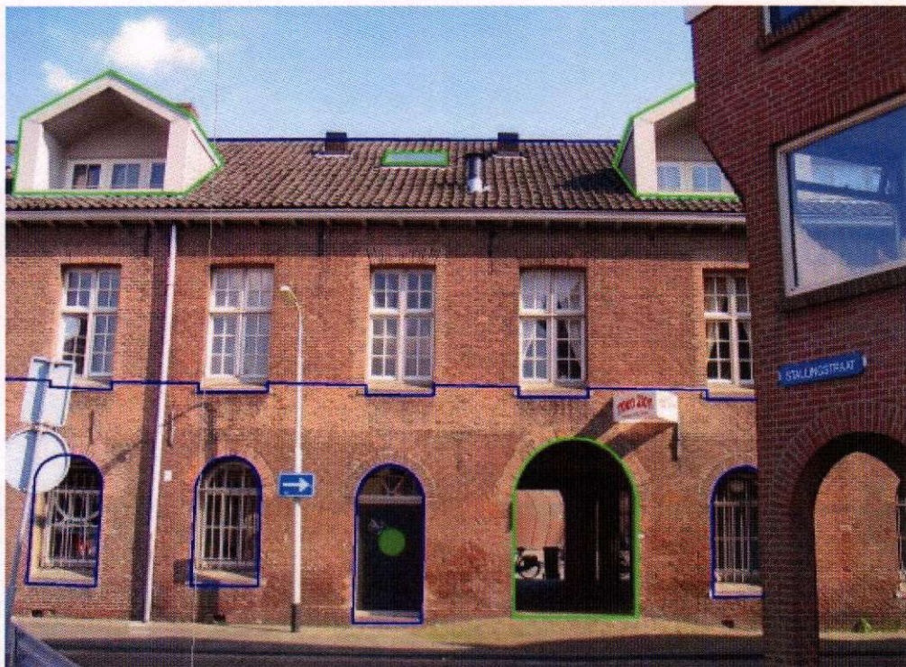
Achter de Lange Stallen (11) De deur heeft, die voorheen een raam was, heeft een afwijkende hoogte en als enige een 19 e eeuwse bovenlicht. De overige bovenlichten zijn 20 e eeuwse.. Ter plaatse van de doorgang zat een raam.
