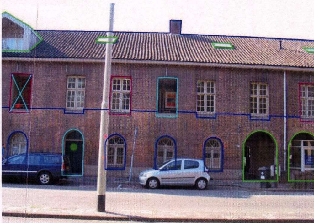
Keizerstraat (9) De linker doorgang was een smalle deur, de rechter een smal raam.
