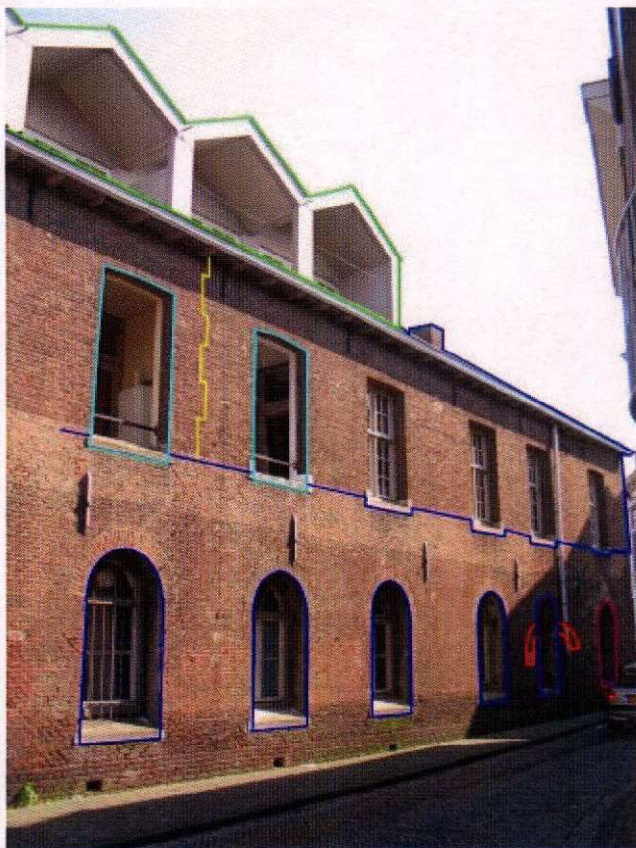
Achter de Lange Stallen (11) De deur heeft, die voorheen een raam was, heeft een afwijkende hoogte en als enige een 19 e eeuwse bovenlicht. De overige bovenlichten zijn 20 e eeuwse.. Ter plaatse van de doorgang zat een raam.
