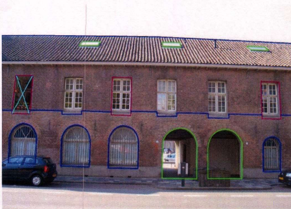
Keizerstraat (4) De linker doorgang was een raam zoals het raam links ernaast. De rechter doorgang was een brede deur.
