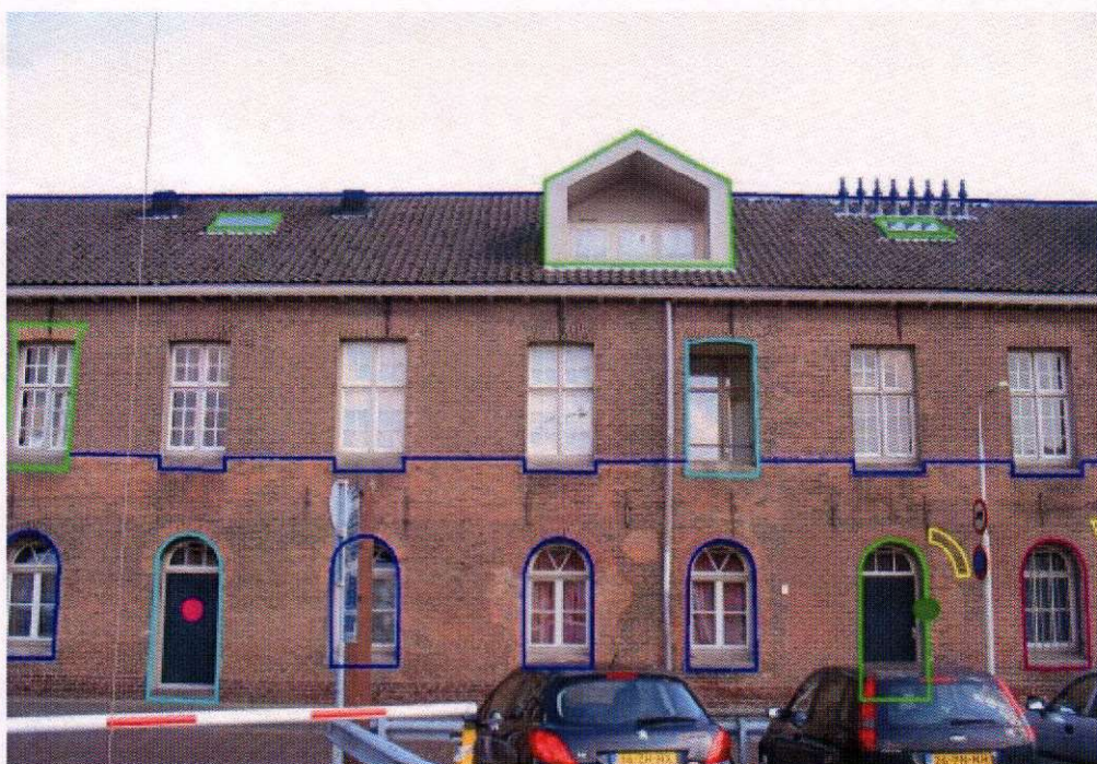
Achter de lange stallen (6) Naast de in 1980-81 nieuw ingebrachte deur zitten de sporen van een 19 e eeuw raam
