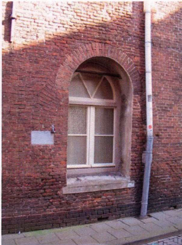
Ramen ingebracht in 1868 op een plek waar een 18 e eeuwse toegang heeft gezeten waarvan de rondboog en hardstenen aanzetstenen nog zichtbaar zijn. Links Achter de Lange Stallen en rechts de Keizerstraat. Boven het raam in de Keizerstraatgevel zijn de sporen zichtbaar van het 18 e eeuwse dakluik.
