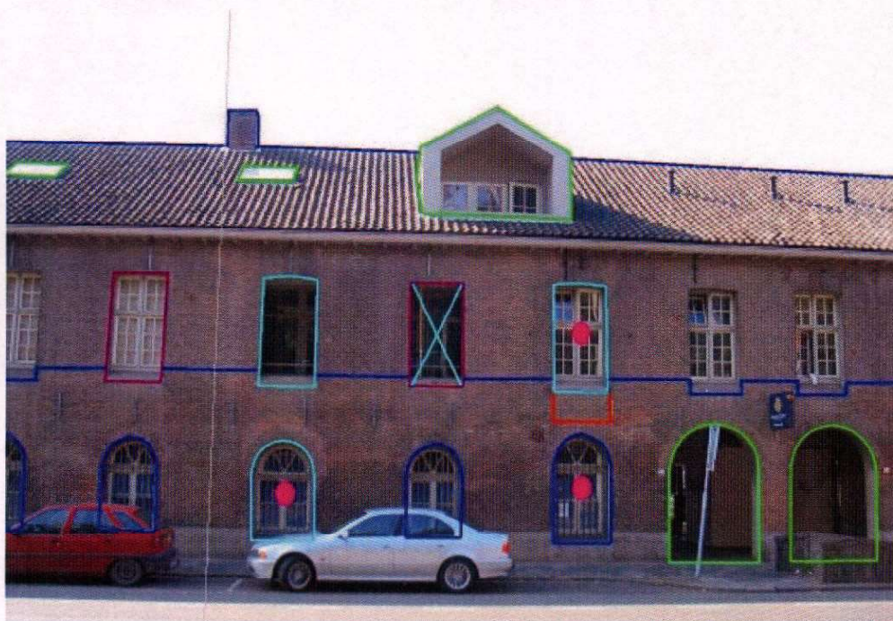
Keizerstraat (11) Ter plaatse van het raam links naast de doorgang heeft een 18 e eeuwse entree gezeten. Hierna is het een hogere deur geworden met op de verdieping een deur voor goederen t.p.v. het voormalige dakluik.
