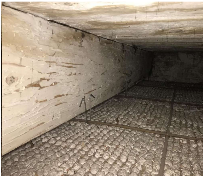
Ruimte onder vloerdelen
