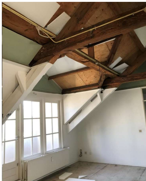
Verbinding tussen de hanenbalk en het spantbeen
