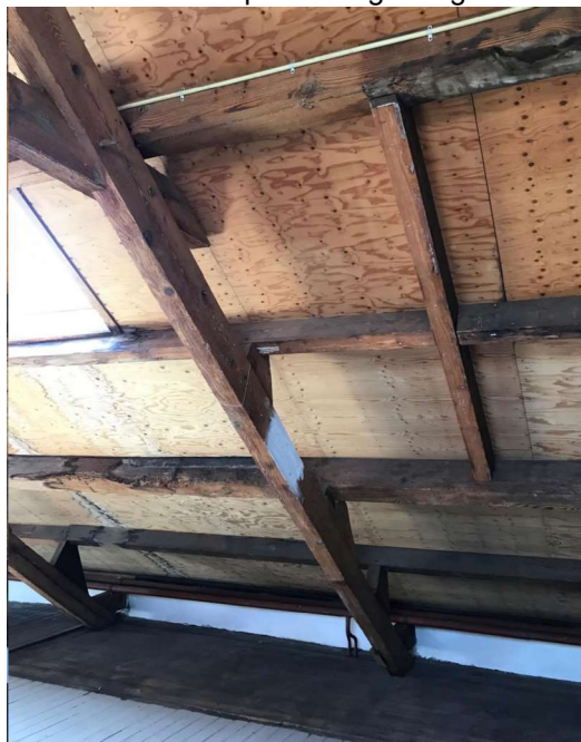
Verbinding tussen de hanenbalk en het spantbeen
