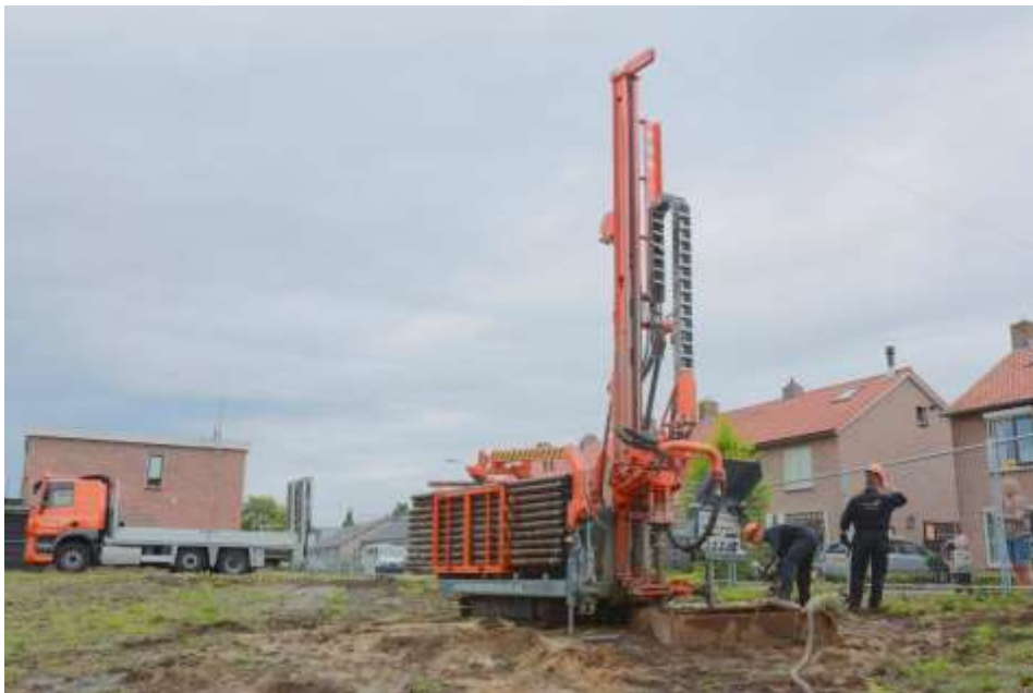
afbeelding 2: Boormachine in het werk
