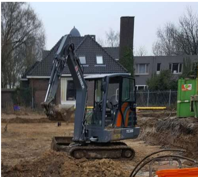
Afbeelding 3: Midi kraan in het werk
