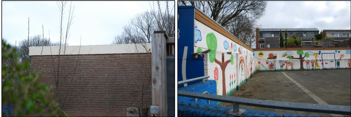
Figuur 5.3. De houten daklijsten aan de school, schuur en stenen schutting is geschikt voor gebouwbewonende vleermuizen om achter weg te kruipen.
