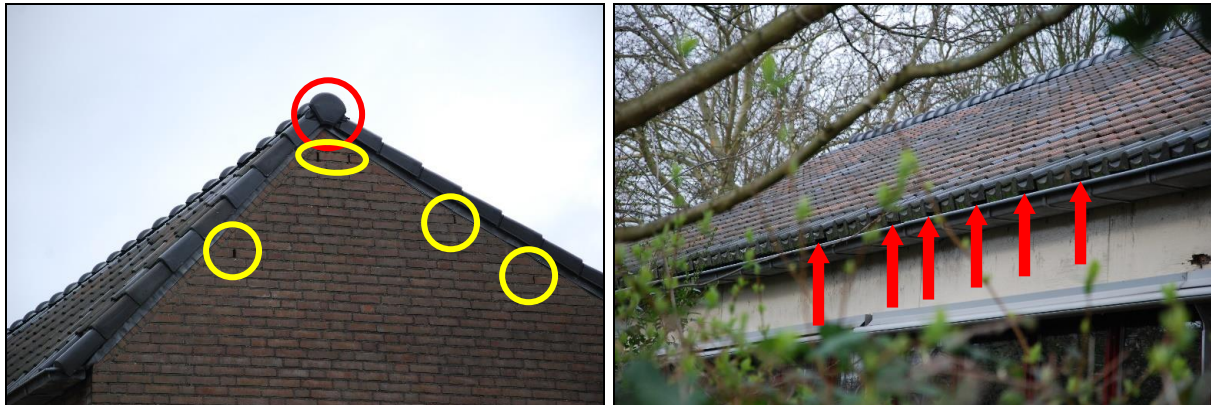
Figuur 5.2. Links: nokpan welke mogelijk geschikt is voor gierzwaluw. rechts: onderste rij dakpannen bevat een dichte rand, maar heeft hier en daar een aantal omhoog geschoven pannen waardoor ruimte is ontstaan.
