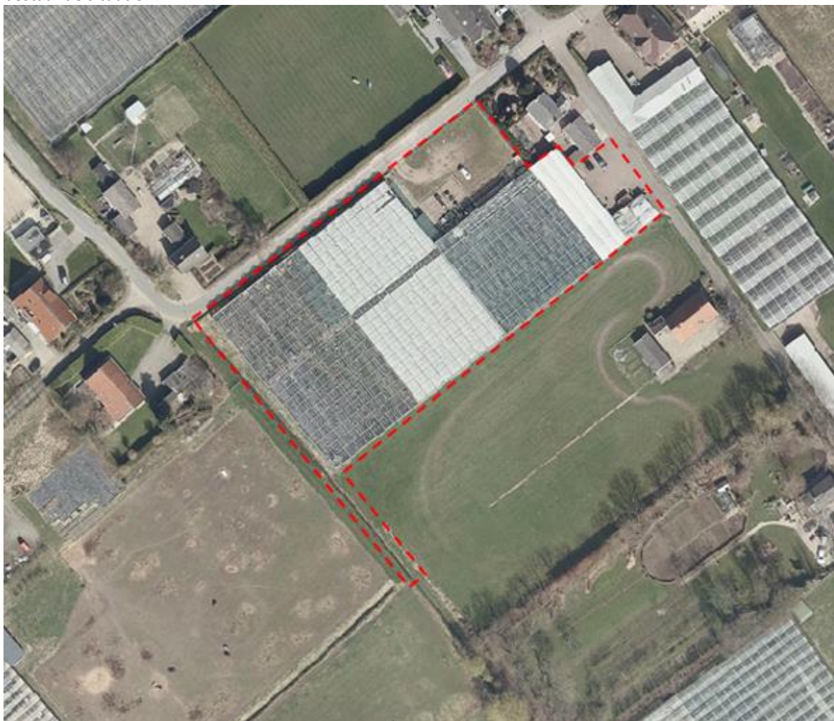
Luchtfoto van het plangebied (bron foto: Omgevingsverordening Gelderland)
