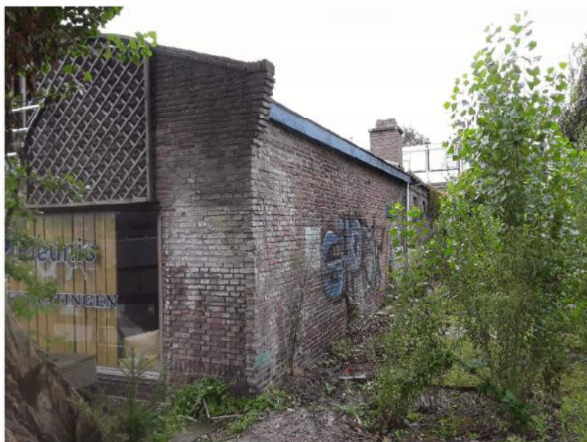
Westeinde 132d, bedrijfsgebouw achterzijde
