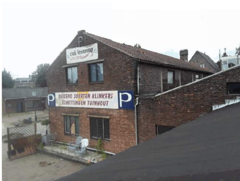
Westeinde 132d, bedrijfsgebouw achterzijde
