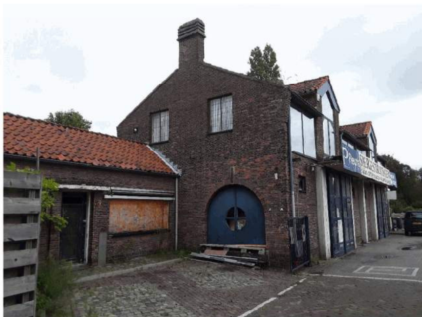
Westeinde 132d, bedrijfsgebouw voorzijde
