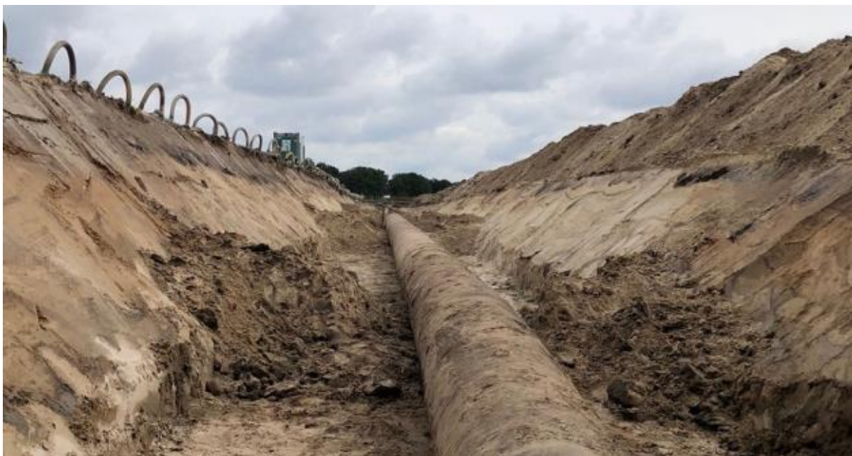
Leiding ligt op de gewenste diepte na het wegscheppen van de zandrug.
