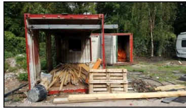
Figuur 4. De open container met opgeslagen bouwmaterialen in het oostelijk deel van de onderzoekslocatie.
