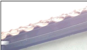
Figuur 9. Ruimten onder de dakpannen van het gebouw op het perceel ten zuidwesten van de onderzoekslocatie.
