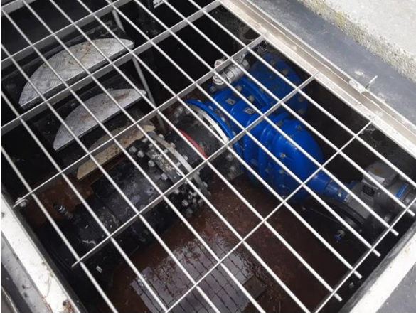
FB01: Impressie voorste gedeelte van het gemaal, dit gedeelte dateert uit 2016.
