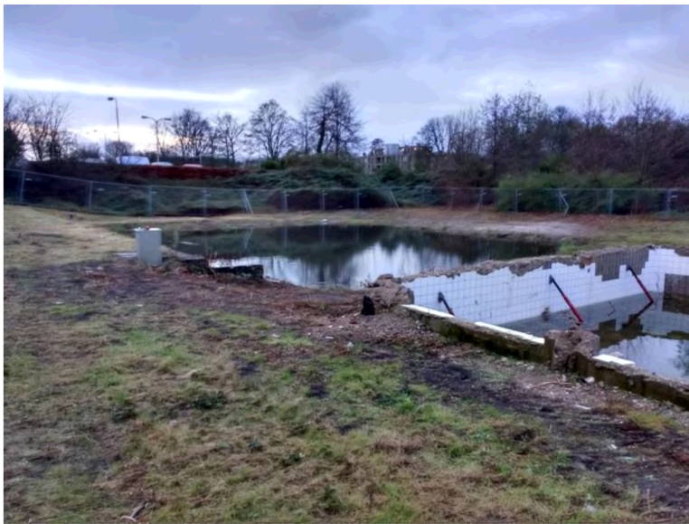
Figuur 7. De overgebleven funderingsputten van de gesloopte gebouwen in het plangebied (Foto door [REDACTED], 2019).
