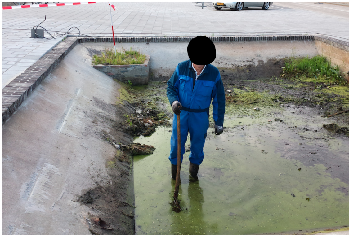
Afbeelding 3 Foto vijverbak tijdens onderhoudswerkzaamheden
