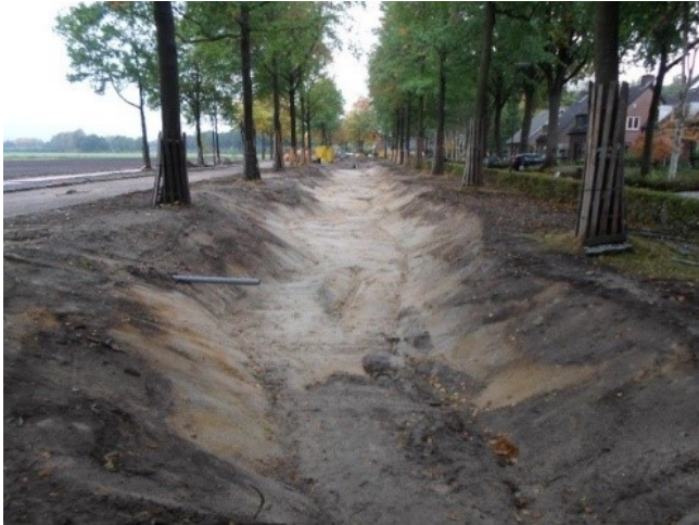
Figuur 5 – Aanleg waterbergingsvoorzieningen Lange Trekken
