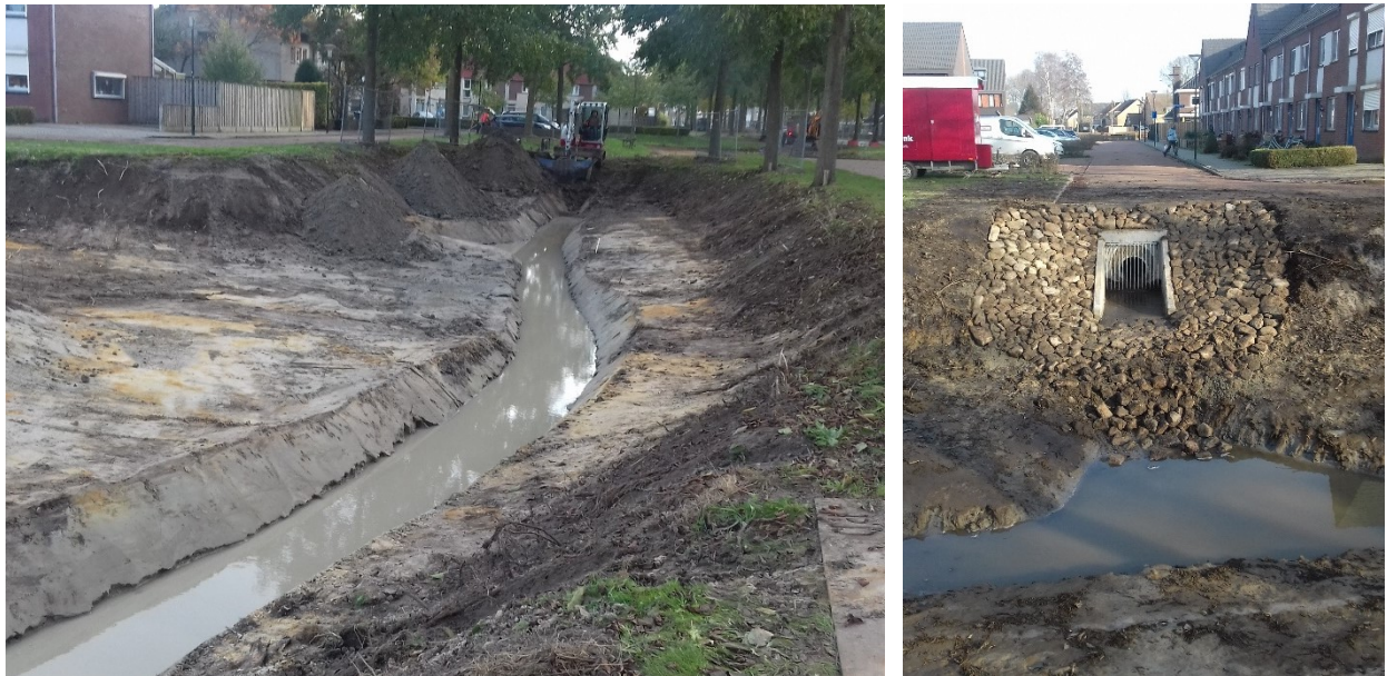
Figuur 9 – Regenwater wordt gebruikt om de vijver te vullen in de wijk De Biezen
