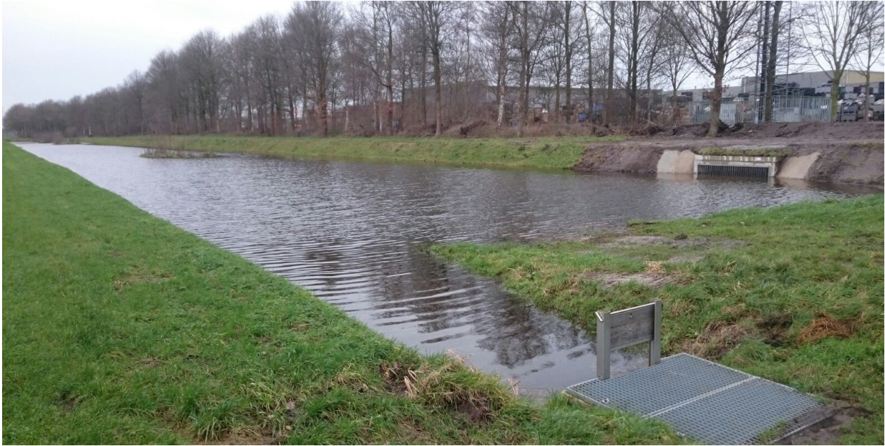
Figuur 10 – Extra regenwaterafvoeren aangelegd op bedrijventerrein De Sleutel. Deze retentievijver voert vertraagt het hemelwater via een stuw naar de Raamsloop
