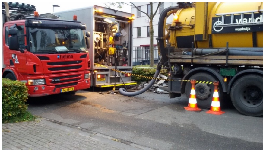
Figuur 6 – Foto reiniging riolering na calamiteit Koster Keunen
