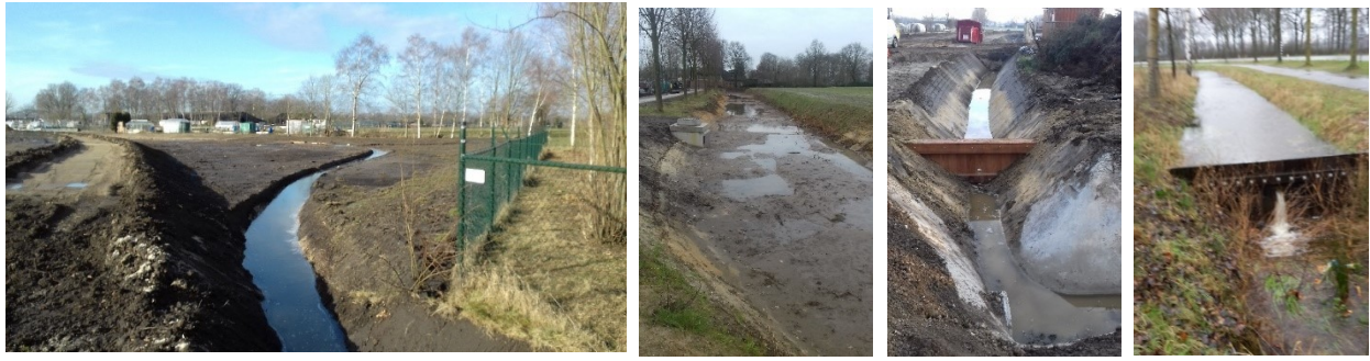
Figuur 8 – Klimaatbuffers aangelegd bij de Randweg Bladel
