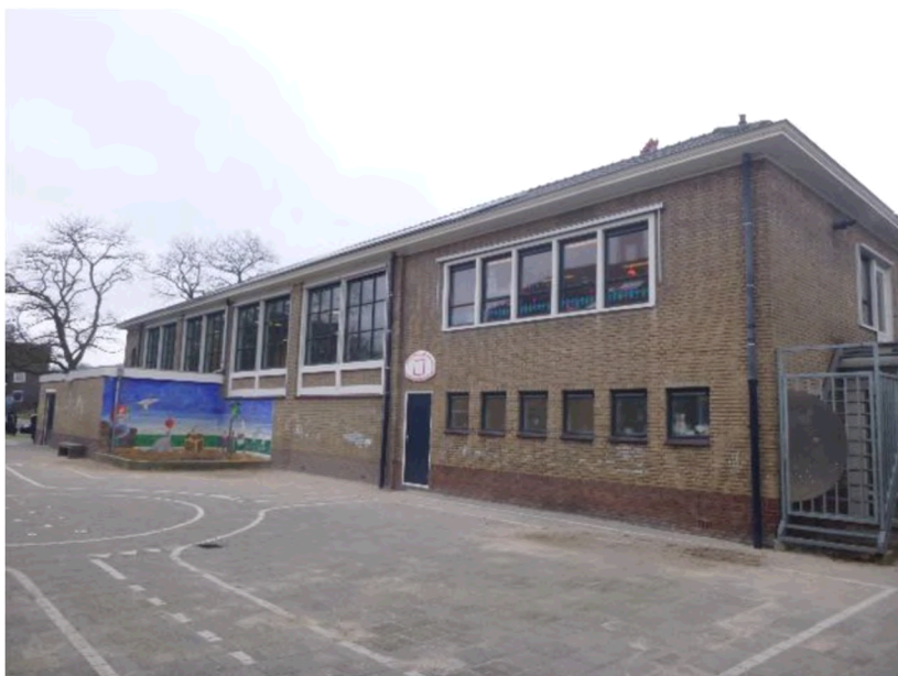
Fig. 3.1 Foto bestaande situatie
