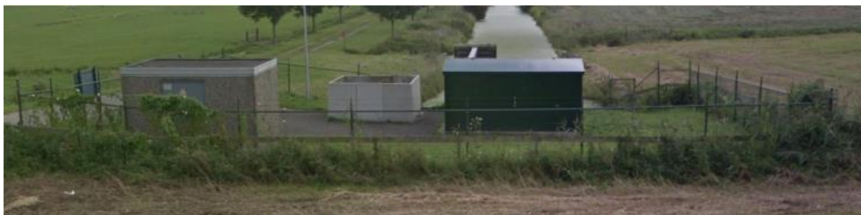
Afbeelding 5 Poldergemaal Starrevaart – huidige situatie 2
