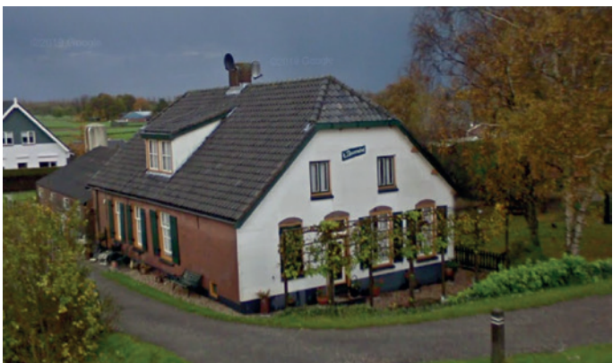
Woning uit 1860 (Maasdijk 4)
