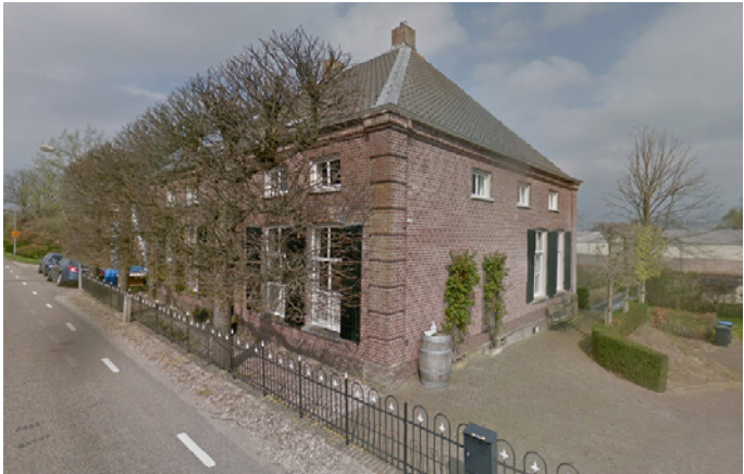
Woning uit 1825 (Maasdijk 12)
