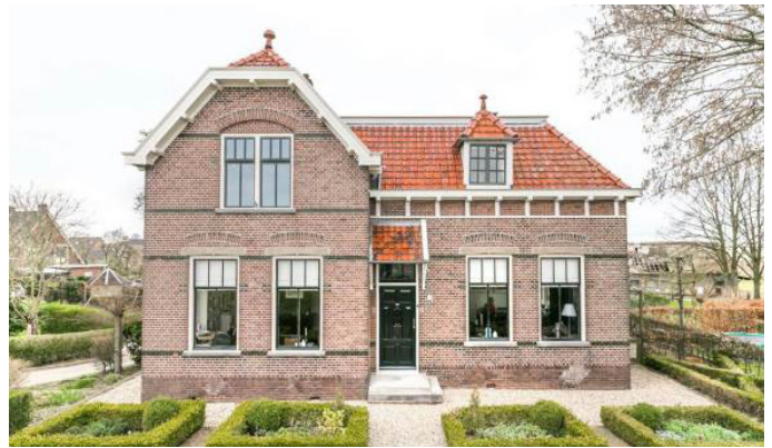
Woning uit 1912 (Maasdijk 14)
