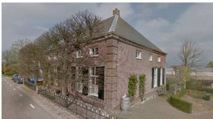
Woning uit 1825 (Maasdijk 12)
