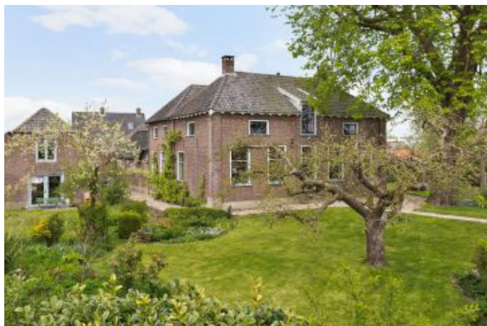
Woning uit 1861 (Maasdijk 16)
