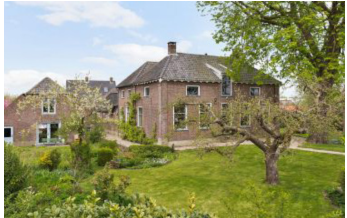
Woning uit 1825 (Maasdijk 16)
