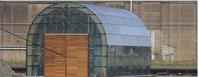
De toren bestaat voornamelijk uit transparante glasplaten waarbij de onder- en boven stijl onderdeel is van de antraciet metalen ringen en de tussen stijlen achter de corten stalen lamellen vallen.
