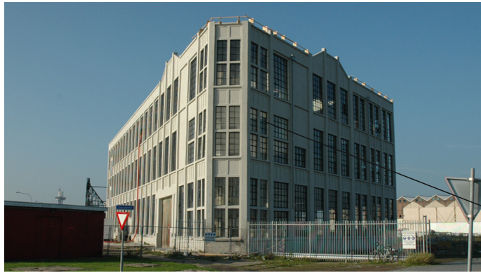
De verticaal georiënteerde raam verdeling van de Timmerfabriek komt terug in de glas indeling van de verdiepingslaag (vloer tot plafond). Dit versterkt de verticaliteit van de toren.
