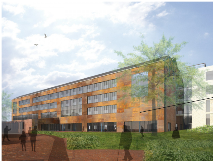
De corten stalen lamellen, geven naast de raam indeling een reliëf aan de gevel. Tegelijkertijd versterken de lamellen de verdraaiing van de toren doordat ze in de taille dichter bij elkaar en in de bolling verder uit elkaar liggen.
