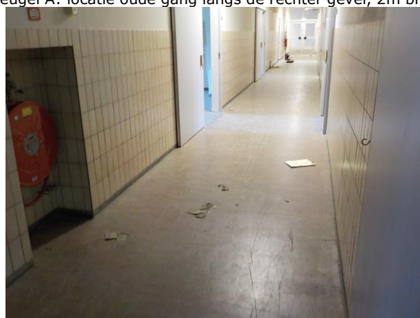
Vleugel A: lijmlaag in de gang, onder egaline en vloerzeil
