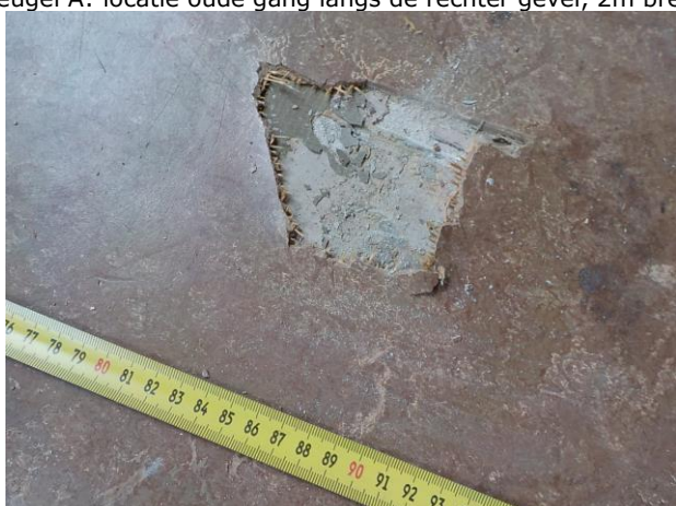
Vleugel A: locatie oude gang langs de rechter gevel, 2m breed. In de 'oude' gang zelf ligt geen lijmlaag
