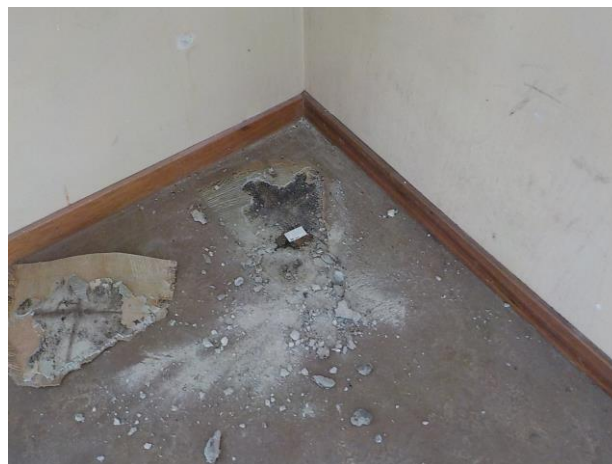
monsternamen locatie M15: vleugel A (1e etage) langs linker gevel
