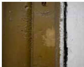
aan de binnenzijde 2 verflagen
