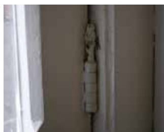
oudste scharnieren met sierkopje
