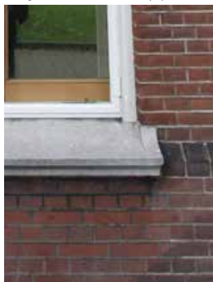
hardstenen lekdoorpel en kalkstenen console
