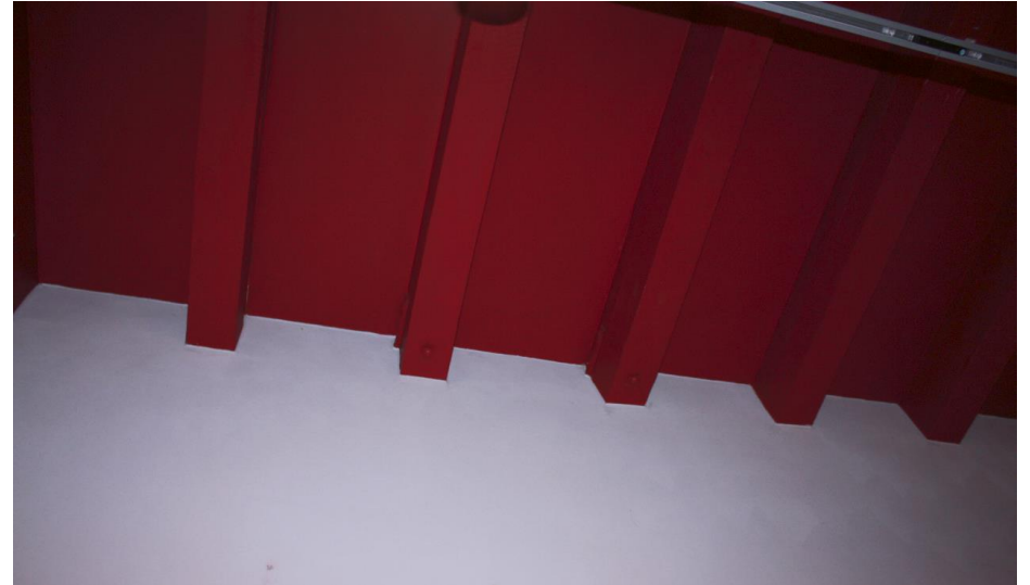
Detail van de enkelvoudige zolderbalklaag in de voorvleugel, ter hoogte van de middenrisaliet.
