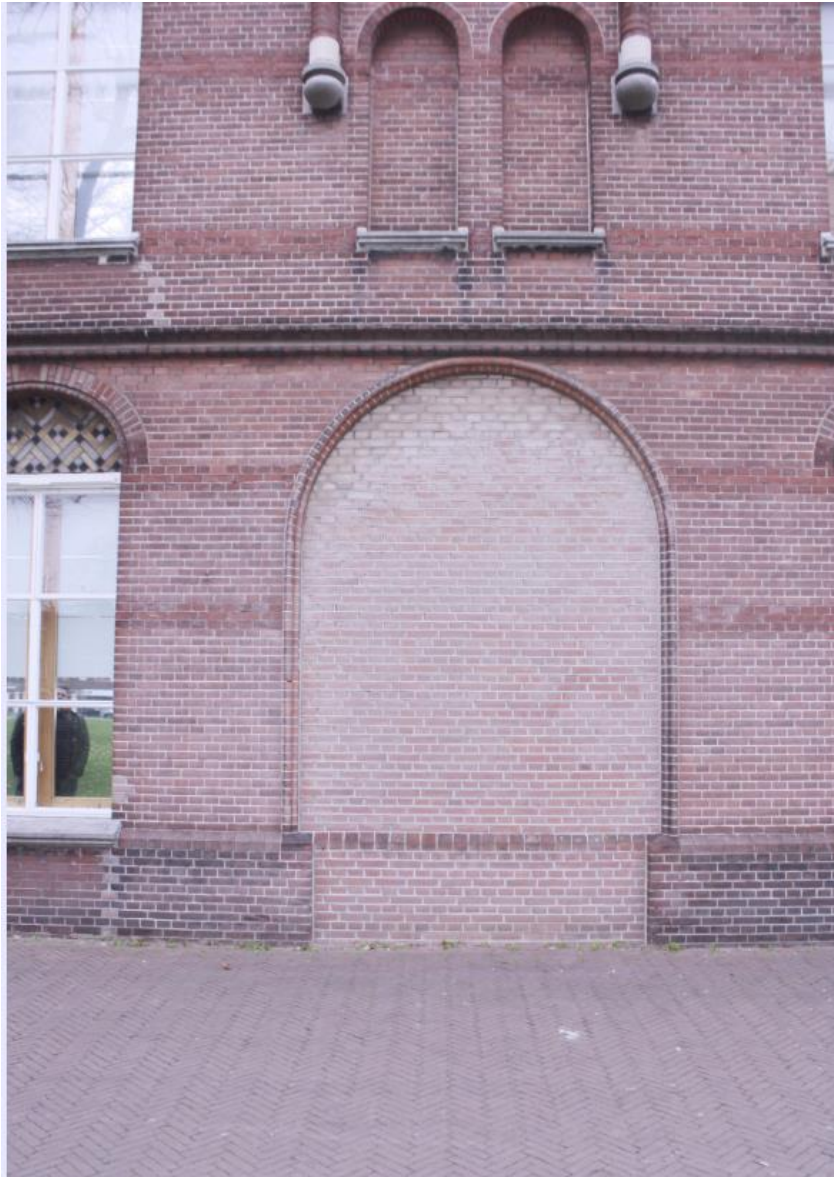
De entree aan de zijkant van de zuidelijke hoekrisaliet is dichtgezet.
