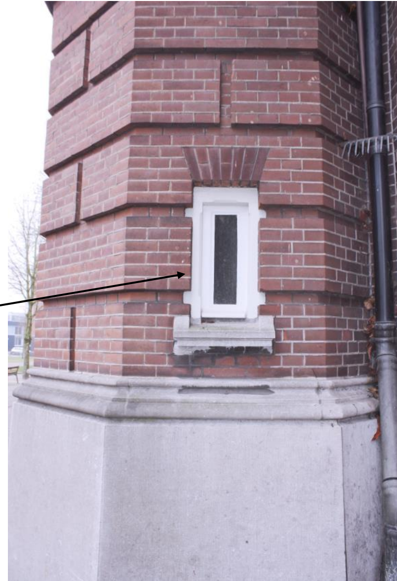
Detail van het oorspronkelijke raam met kozijn op de begane grond in de rechter hoektoren.
