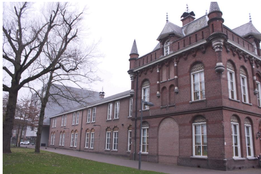
De zuidelijke hoekrisaliet met aansluitende achtervleugel, gezien richting het westen.
