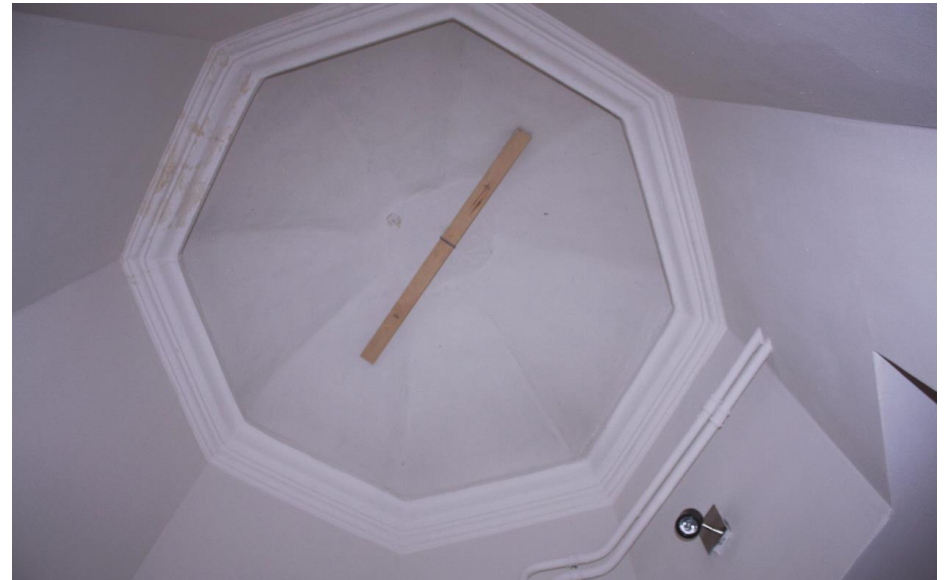
Het stenen gewelf boven de verdieping in een van de hoektorens.
