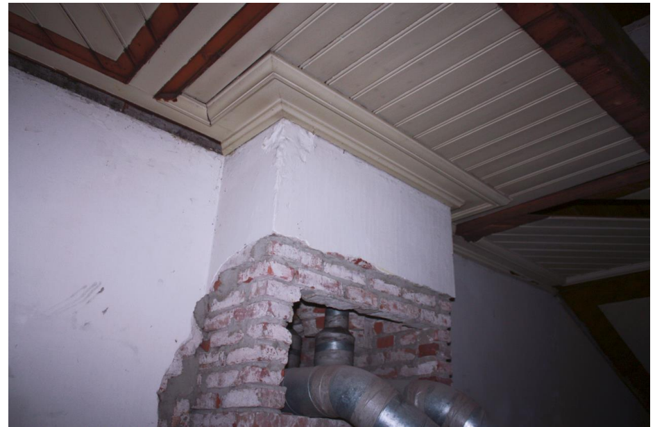
De met kraalschroten en geprofileerde lijsten betimmerde plafonds boven de verdieping van een van de achternvleugels.
