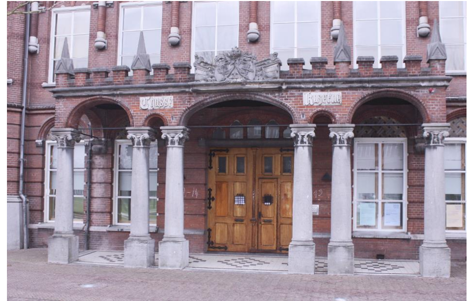
De galerij voor de entree in de middenrisaliet bestaat uit hardstenen zuilen met kapitelen op basementen en gemetselde muur- en scheibogen.
