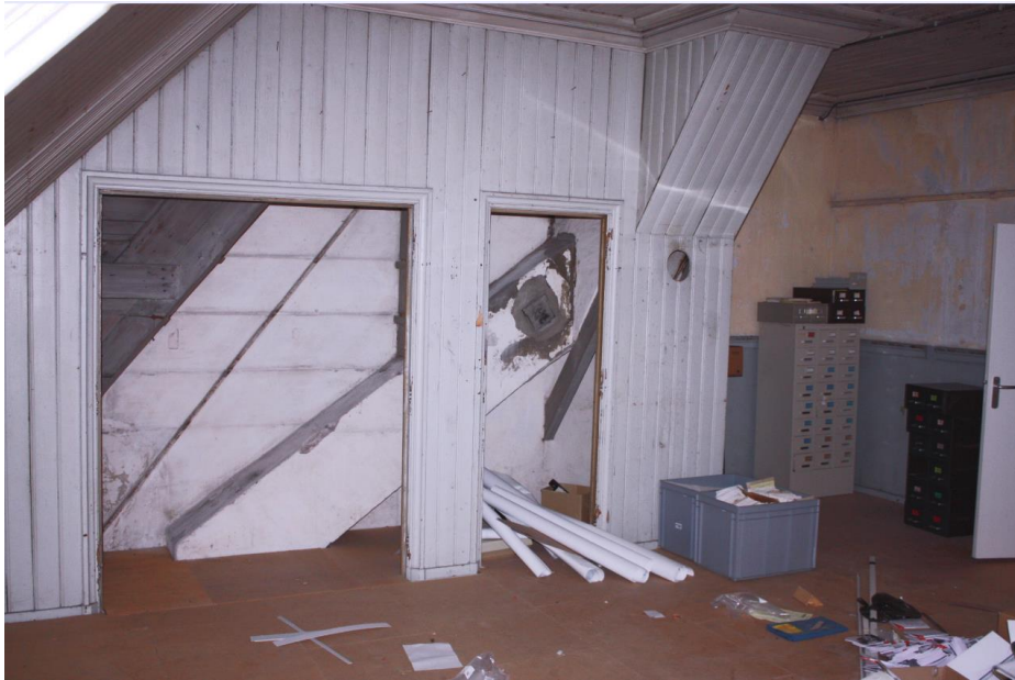
Het leslokaal op de zolder van de zuidelijke hoekrisaliet heeft nog de oorspronkelijke inbouwkasten.
