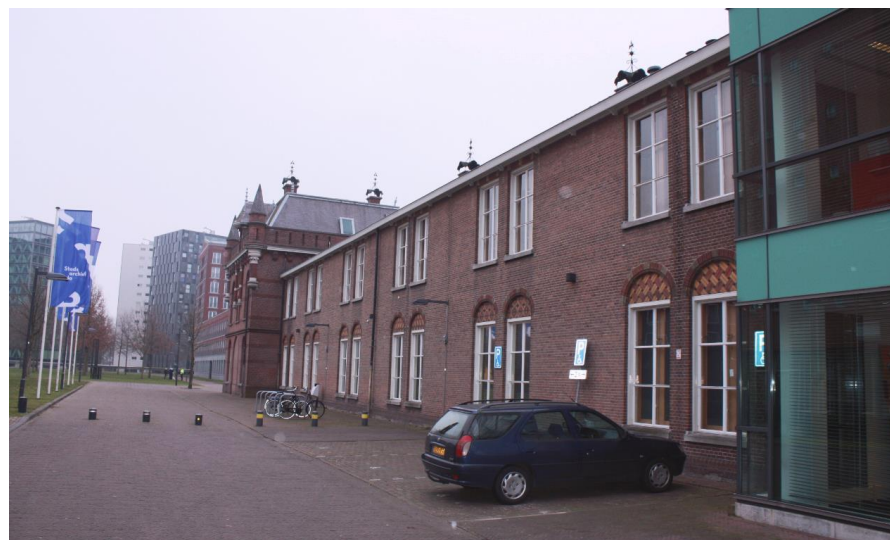
De noordelijke hoekrisaliet met aansluitende achtervleugel, gezien richting het oosten.
