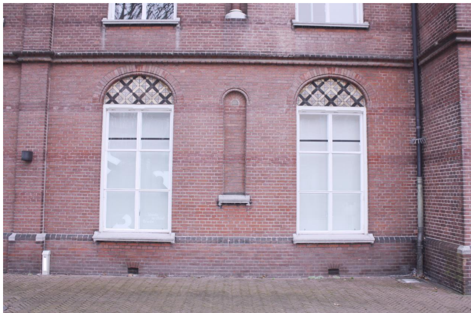
Detail van een nis op de begane grond in de geveldelen tussen de risalieten. De boogtrommels boven de vensters zijn gevuld met siermetselwerk in grijs, geel en zwart gekleurde stenen.
