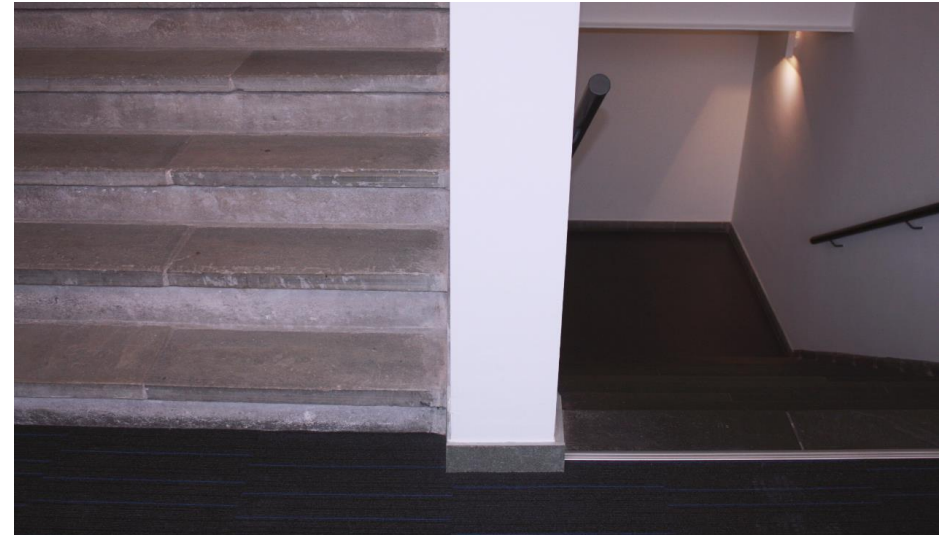
De oude natuurstenen treden van de verdieping naar de zolder (links) en de vernieuwde natuurstenen treden van de begane grond naar verdieping (rechts) in een trappenhuis in een van de achtervleugels.
