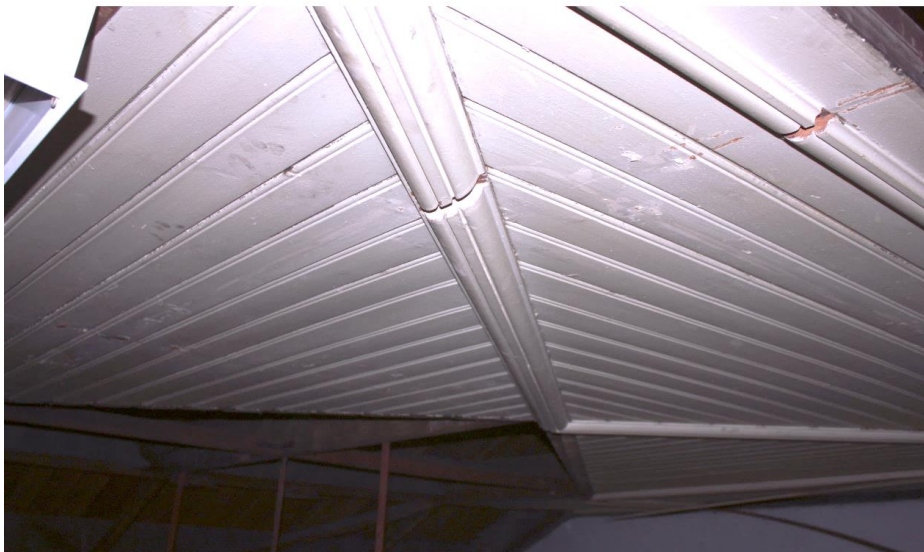
Detail van de oorspronkelijke diagonaal geplaatste kraalschroten boven de verdieping van een van de achtervleugels.
