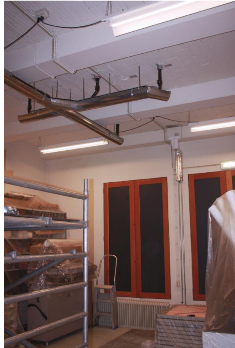
De achterzijde van de noordelijke achternvleugel heeft een verdiepingsvloer van holle keramische stenen met onderslag.
