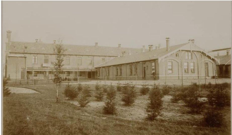
Zicht op de achterzijde van de Emmakazerne te Assen met rechts een éénlaags legeringsvleugel. Tegen de achtergevel van de tweelaags voorbouw is een afdak op kolommen boven de eerste bouwlaag aanwezig! Geheugen van Nederland.
