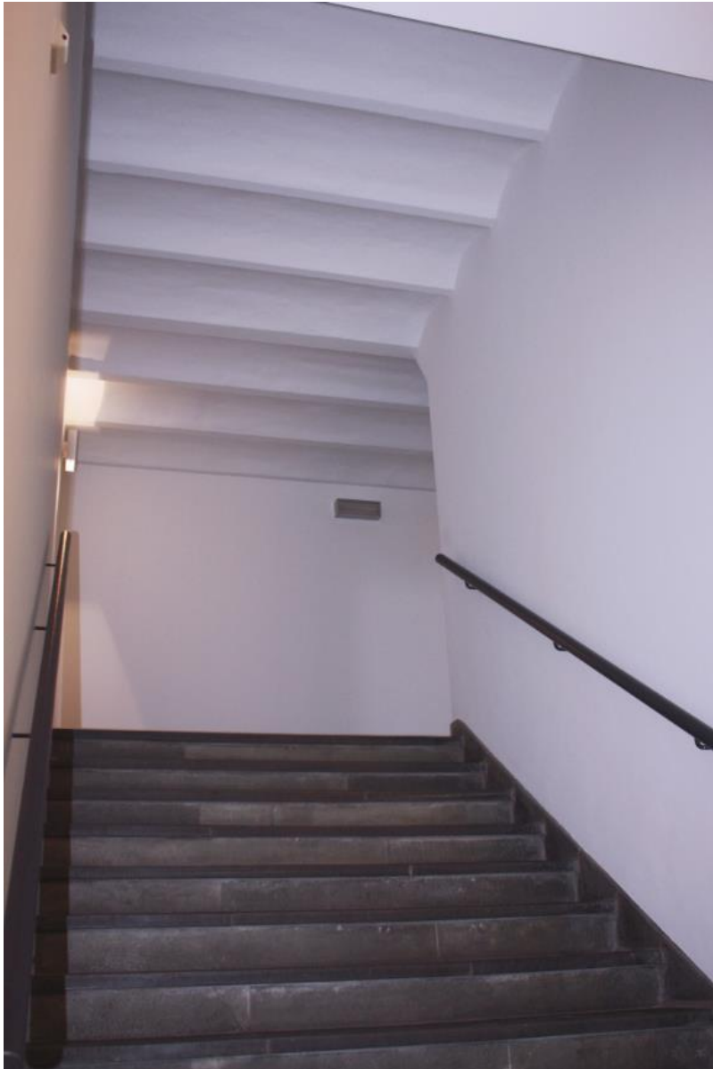
Een trappenhuis van de begane grond naar de verdieping in een van de achtervleugels. De natuurstenen delen van de treden en plint zijn vervangen.
