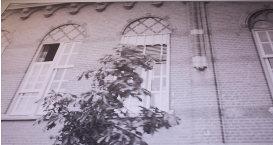
Detail van een foto uit 1939, genomen aan de voorzijde van de kazerne. De vensters in de geveldelen tussen de risalieten waren op de verdieping voorzien van schuiframen, met een schuifbaar onder en bovendeel. Sommige ramen waren voorzien van zonweringen, zoals het venster rechts. GAB.
