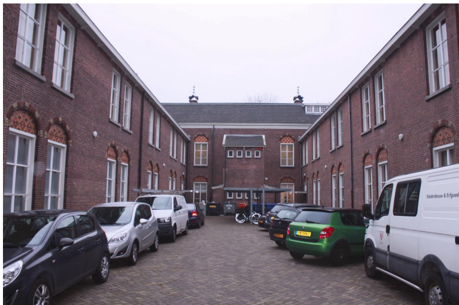
De achtergevel van de voorvleugel en de zijgevels van de achtervleugels (links en rechts), gezien naar het oosten.
