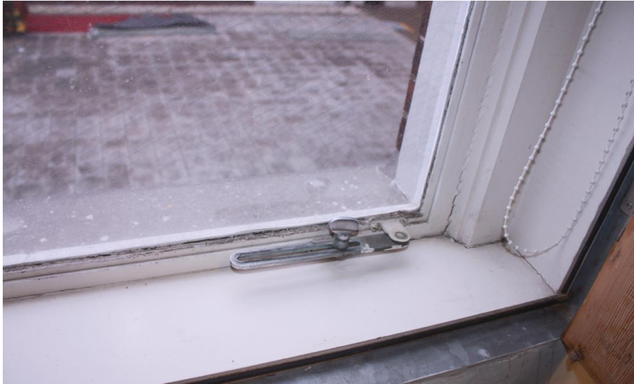
Detail van het draaiwerk van een stalen raampartij op de begane grond van een van de achtervleugels.
