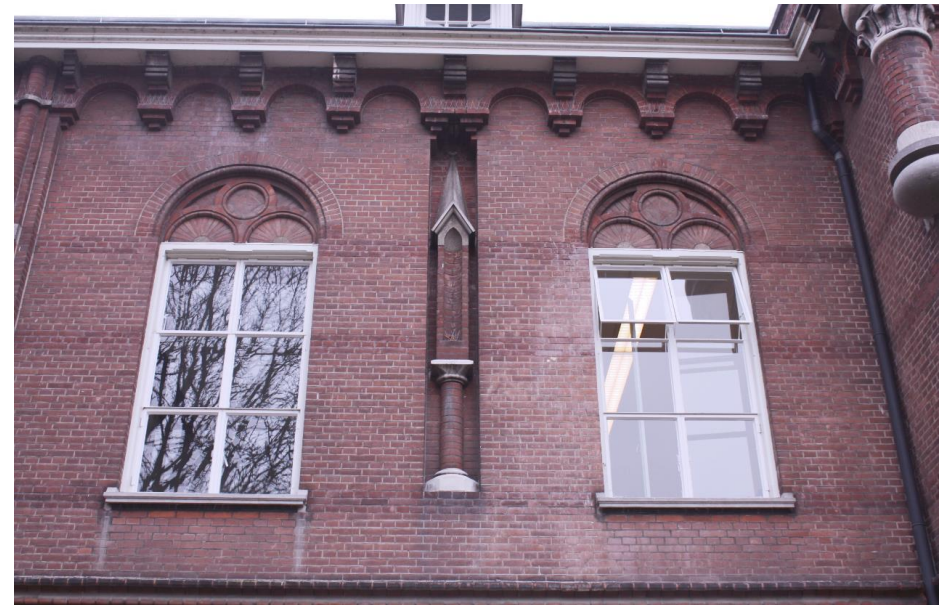
Oorspronkelijke kozijnen op de verdieping van de voorvleugel.
