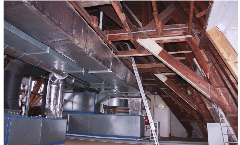
Boven de middenrisaliet bestaat de kapconstructie uit dezelfde dekbalkjukken maar dan zijn er gestapelde stijlenparen met geschoorde middenstijlen aangebracht.
