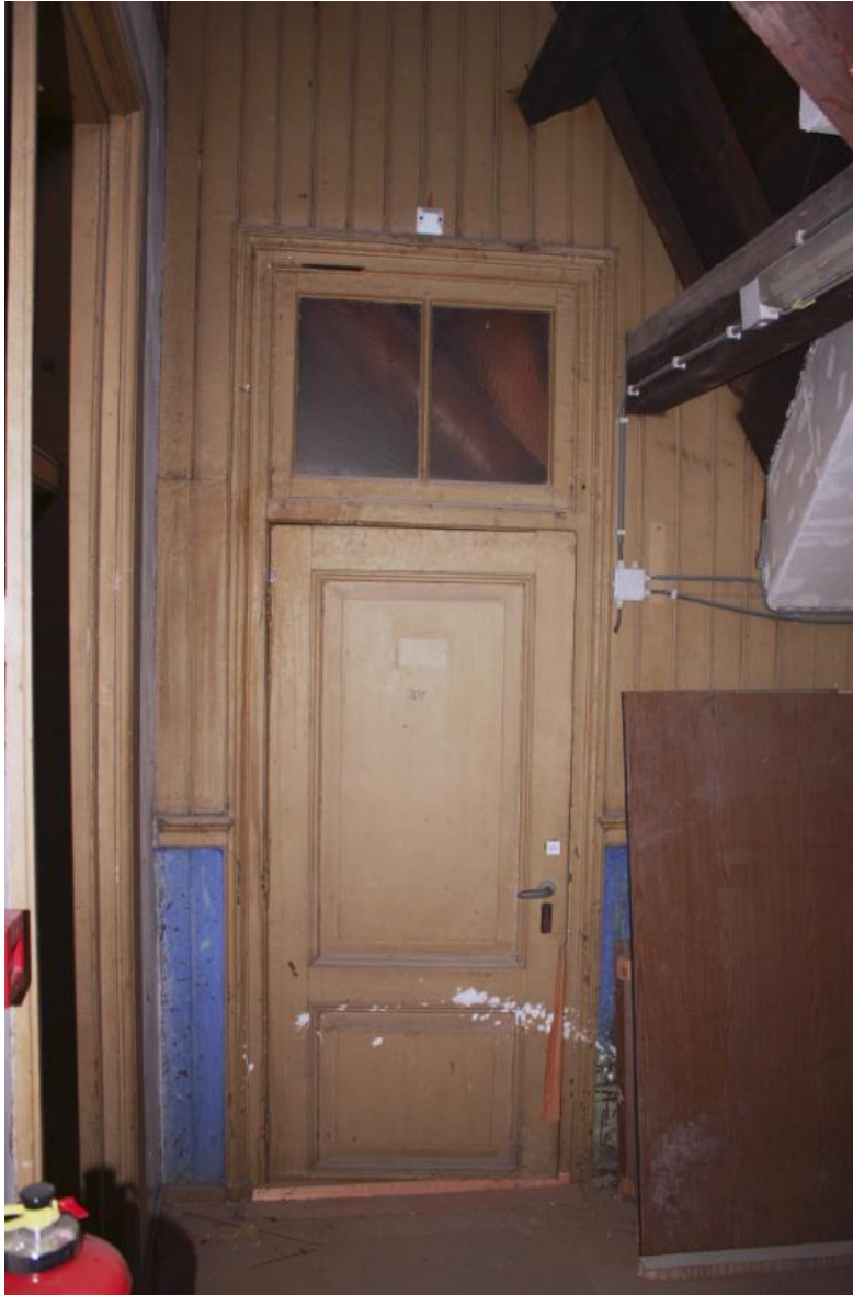
De hal op de zolder van de noordelijke hoekrisaliet met de oorspronkelijke paneeldeuren met bovenlicht, schroten als wandafwerking en okergele en kobaltblauwe verfkleur.
