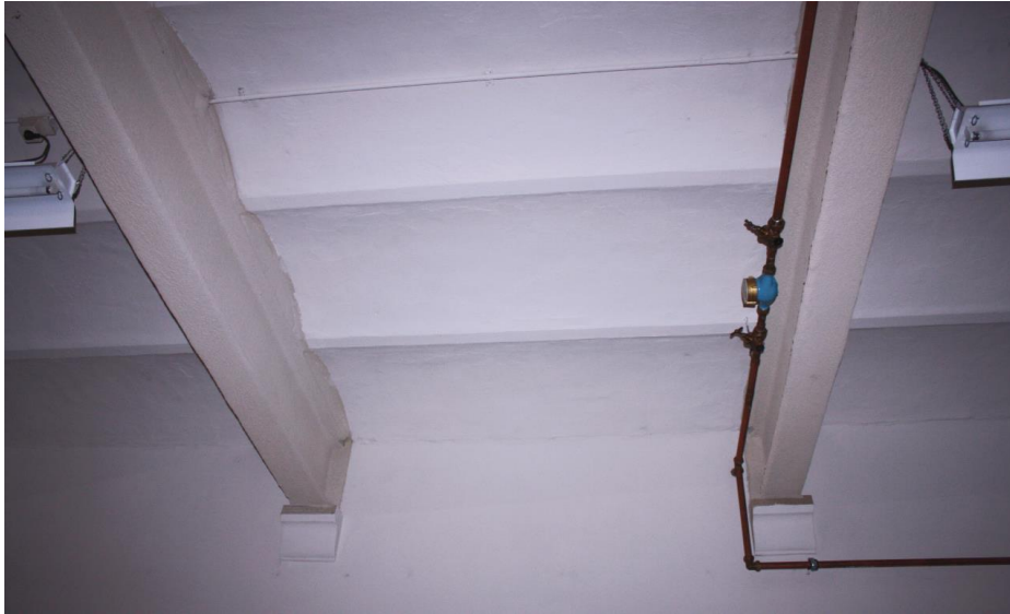
Troggewelven met stalen onderslagbalk op hardstenen consoles vormen de verdiepingvloer bij de achtervleugels.
