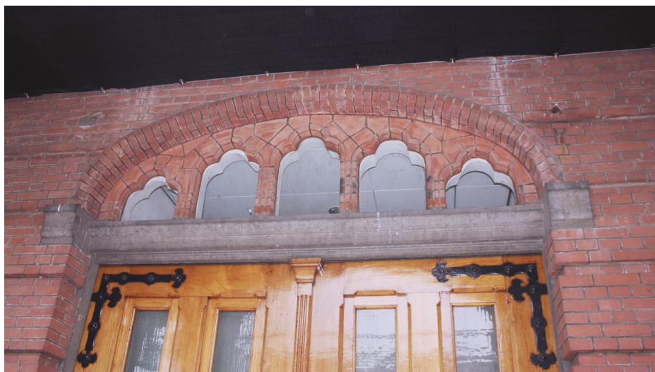
Detail van het bovenlicht boven de hoofdentree.
