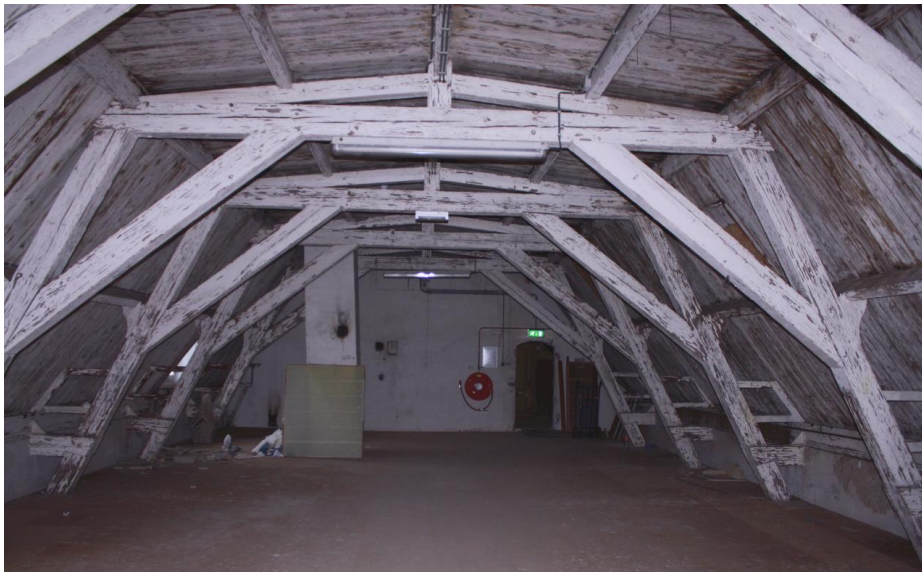
De kapconstructie boven de lagere delen van de voorvleugel hebben een traditionele opbouw van dekbalkjukken met rechte spantbenen.
