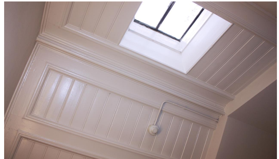
De oorspronkelijke plafonds boven het trappenhuis in de bestaan uit kraalschroten met lijstwerk.
