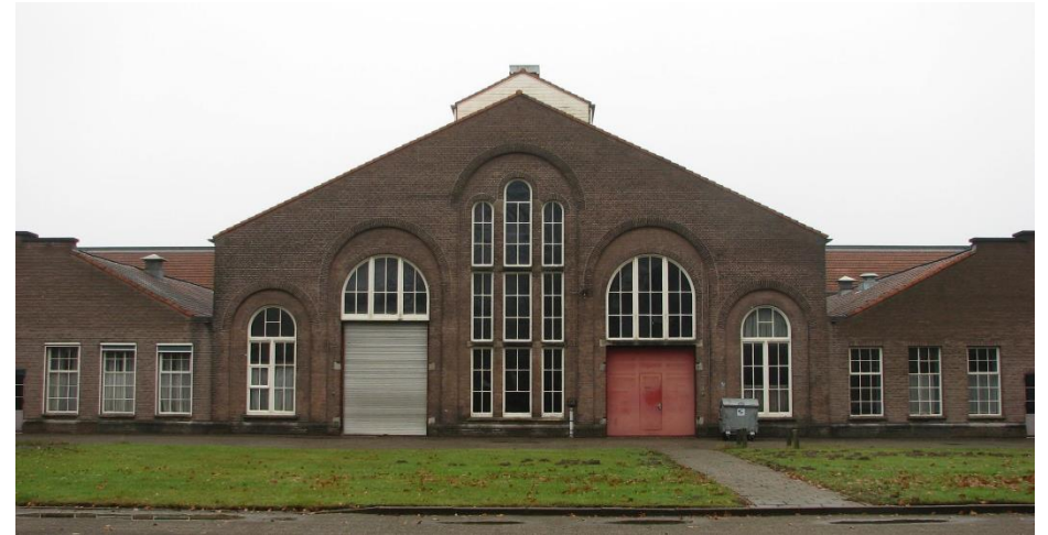
Zicht op de bakstenen achtergevel van de overkapte exercitieplaats van de Frisokazerne in Ede. MAB 2009
