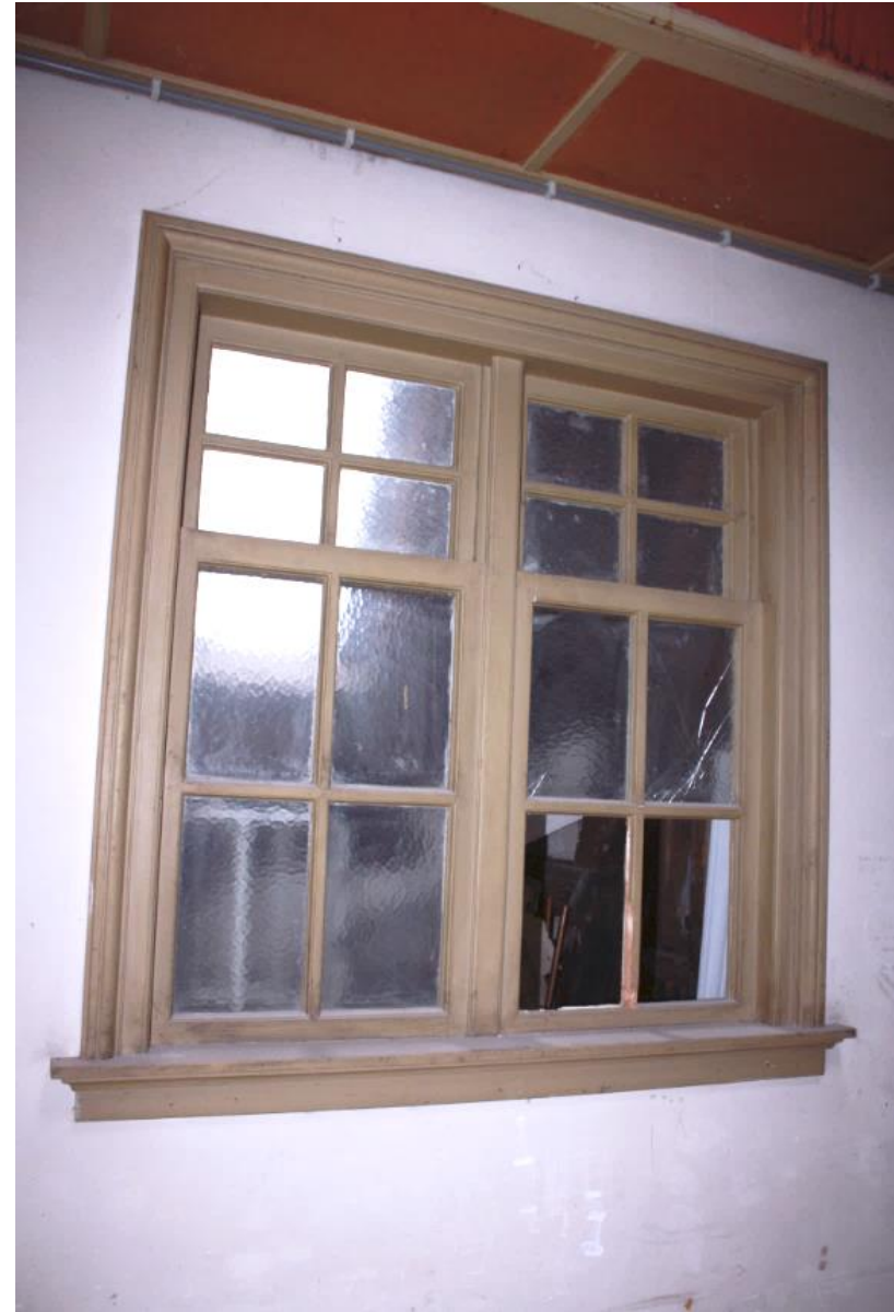
Detail van het schuifbare binnenvenster in het leslokaal op de zolder van de noordelijke hoekrisaliet.
