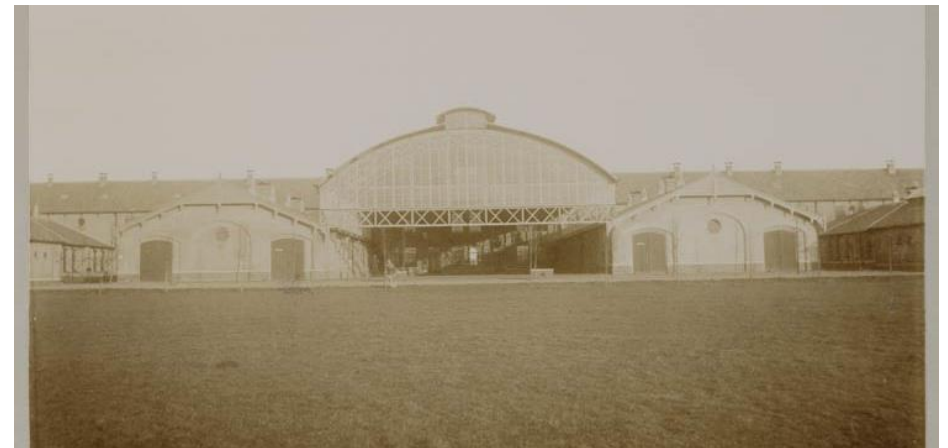
Zicht op de achterzijde van de Wilhelminakazerne te Assen met de ijzeren en glazen overkapping van de exercitieplaats, ingeklemd tussen de twee legeringsvleugels. Foto van kort na de bouw in 1893/4 Geheugen van Nederland.
