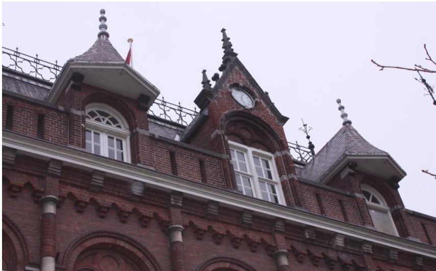
Detail van de dakkapel met tuit en sierwerk in hardsteen en de flankerende kapellen met schilddak op overstek en pironnen boven de middenrisaliet. Achter de kapellen is nog een deel van het dakhek zichtbaar.
