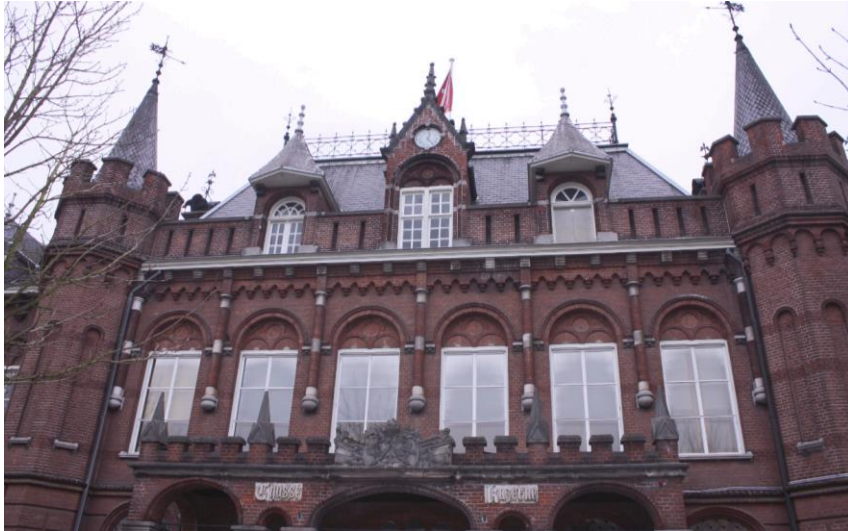
De verdieping van de middenrisaliet is voorzien van halfzuilen tussen de vensters. De torenspitsen zijn voorzien van windvanen.
