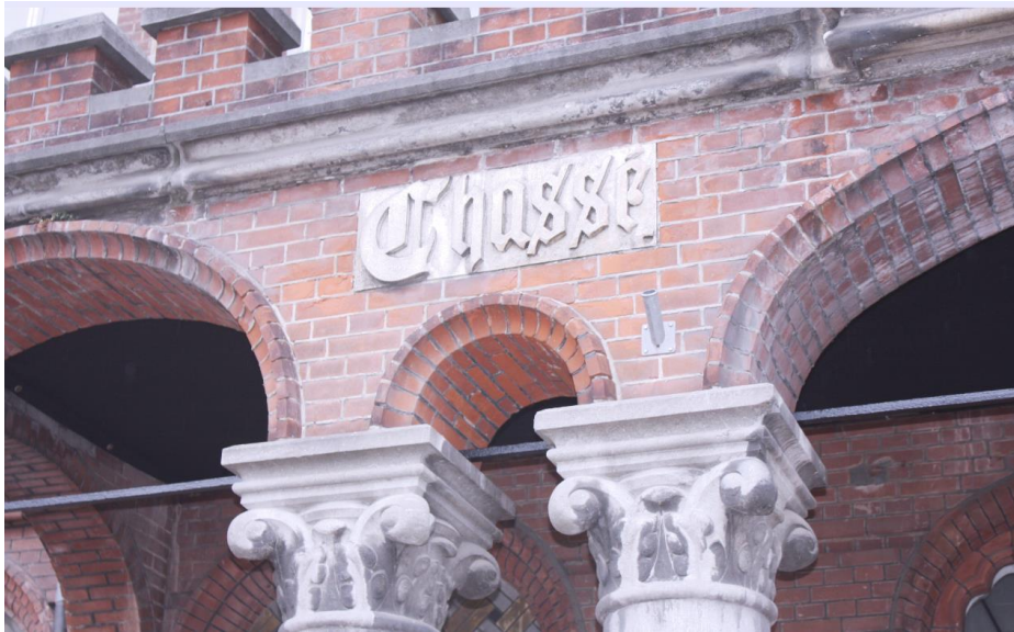
Detail van de kapitelen van de galerij en de hardstenen plaquette waarop het woord CHASSÉ in reliëf is aangebracht.
