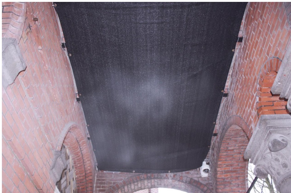
De overveling van de galerij is met troggewelven tot stand gekomen. In den huidige situatie zijn de gewelven met een doek behangen.
