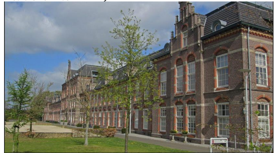
De neorenaissance-invloeden zijn ook zichtbaar bij de infanteriekazernes uit de vroege 20 ste eeuw, zoals hier bij de Snijderskazerne in Nijmegen uit 1906. Ook de Kraijenhoffkazerne in Nijmegen is zo opgezet en uitgevoerd. De architectuur is exact gelijk aan die van de Maurits en Frisokazerne in Ede.
