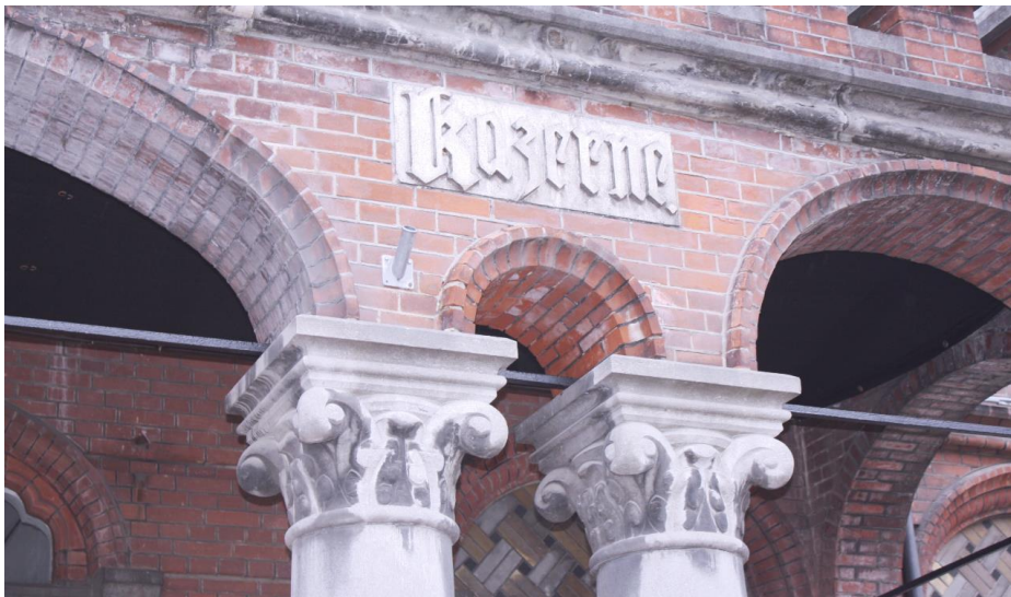
Detail van de kapitelen van de galerij en de hardstenen plaquette waarop het woord KAZERNE in reliëf is aangebracht.
