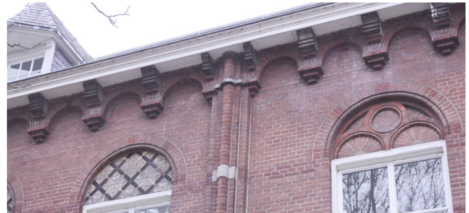
Detail van het boogfries en de hardstenen consoles in de voorgevel.
