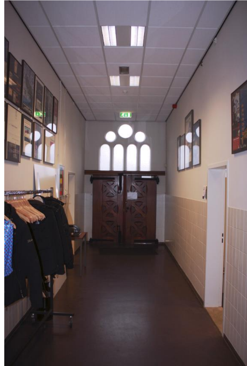
De oorspronkelijke entree van houten paneeldeuren onder een bovenlicht met rondboog in de zuidelijke hoekrisaliet.
