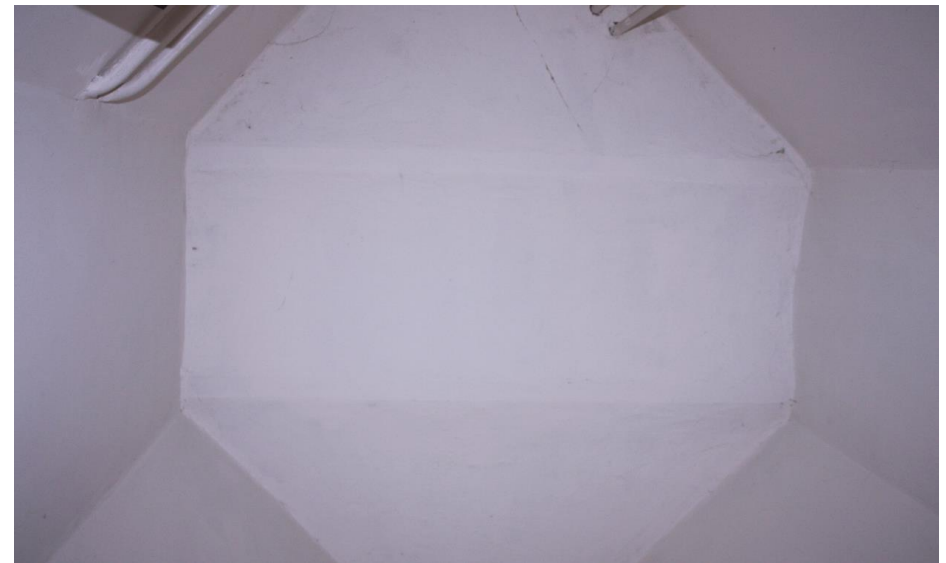
Detail van het troggewelf boven de begane grond van de hoektorens.
