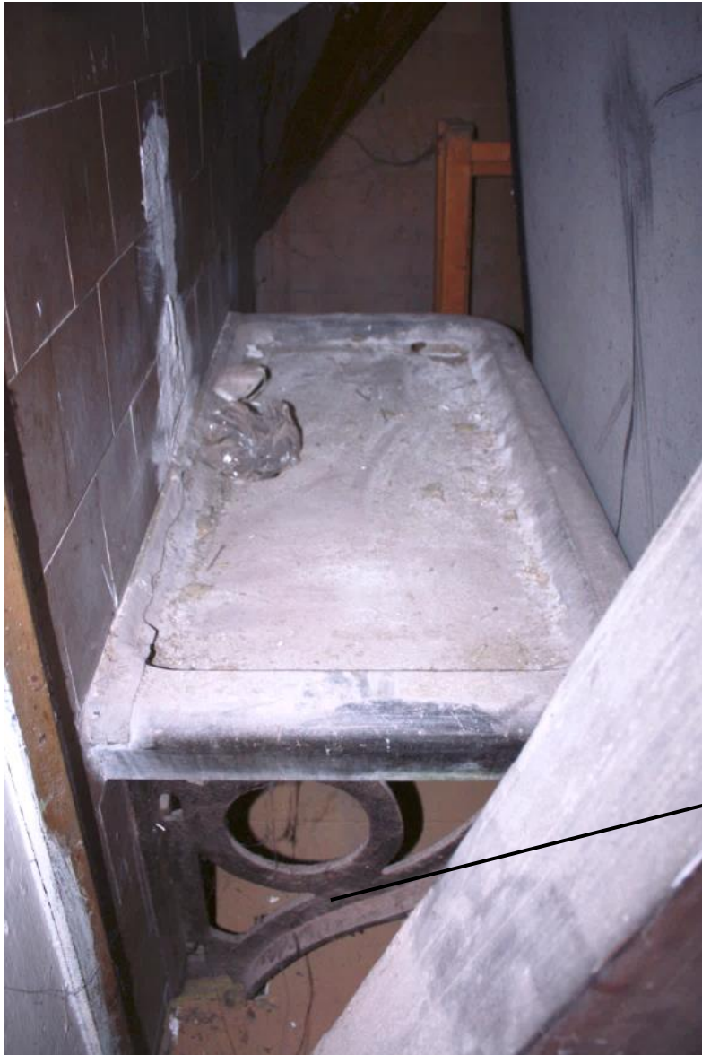
De originele wastafel in de hal van de zolder boven de noordelijke hoekrisaliet.
