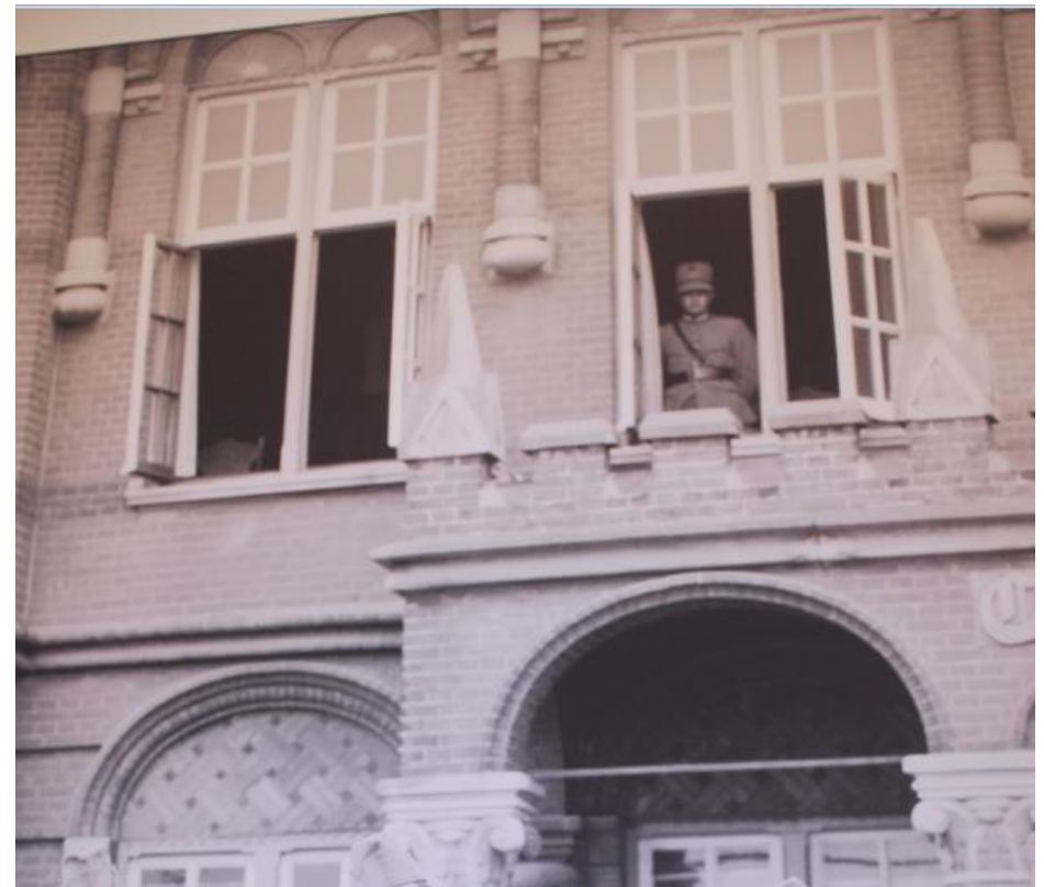
Detail van een foto uit 1939, genomen aan de voorzijde van het gebouw. De vensters op de verdieping van de middenrisaliet zijn ingezet met draairamen. De figuur achter het venster staat ter plaatse van de officiersruimte. GAB.
