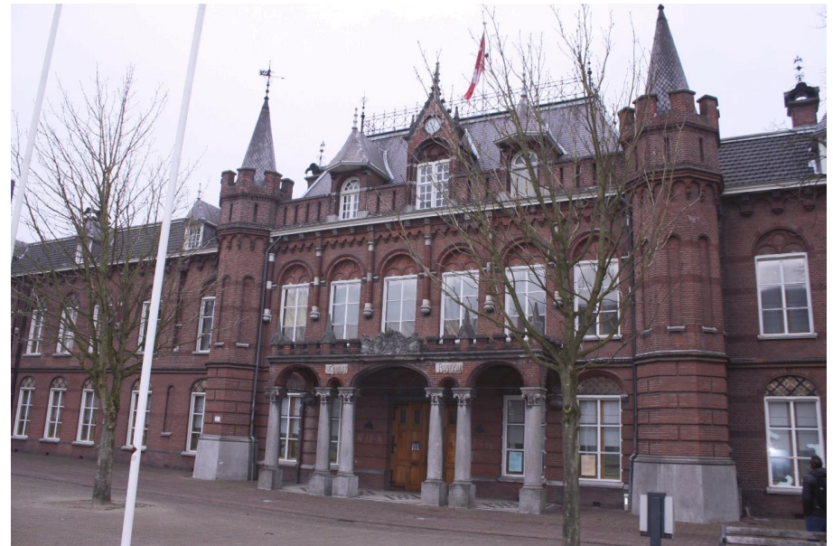
De middenrisaliet wordt geflankeerd door hoektorens met hardstenen plint.
