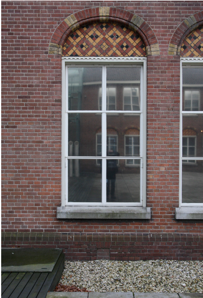
het onderzochte venster in de vleugel
