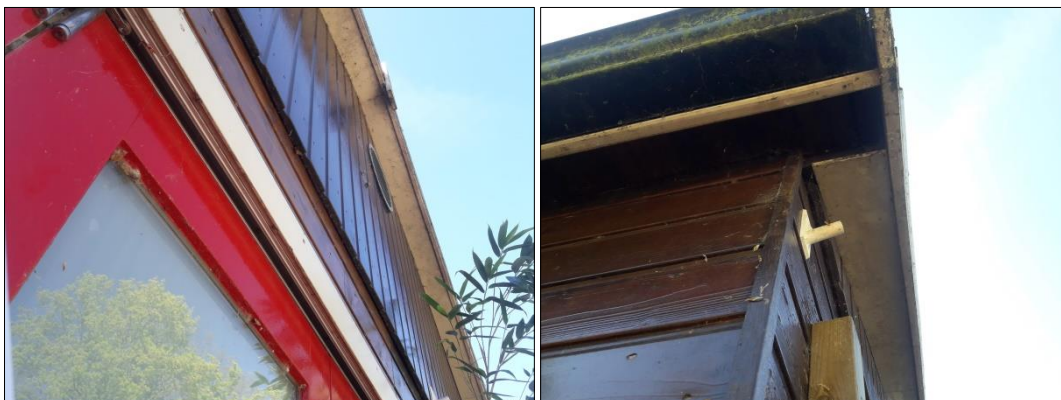
Figuur 3.1 a en b. Diverse openingen in de houten betimmering in het horeca-gebouw
