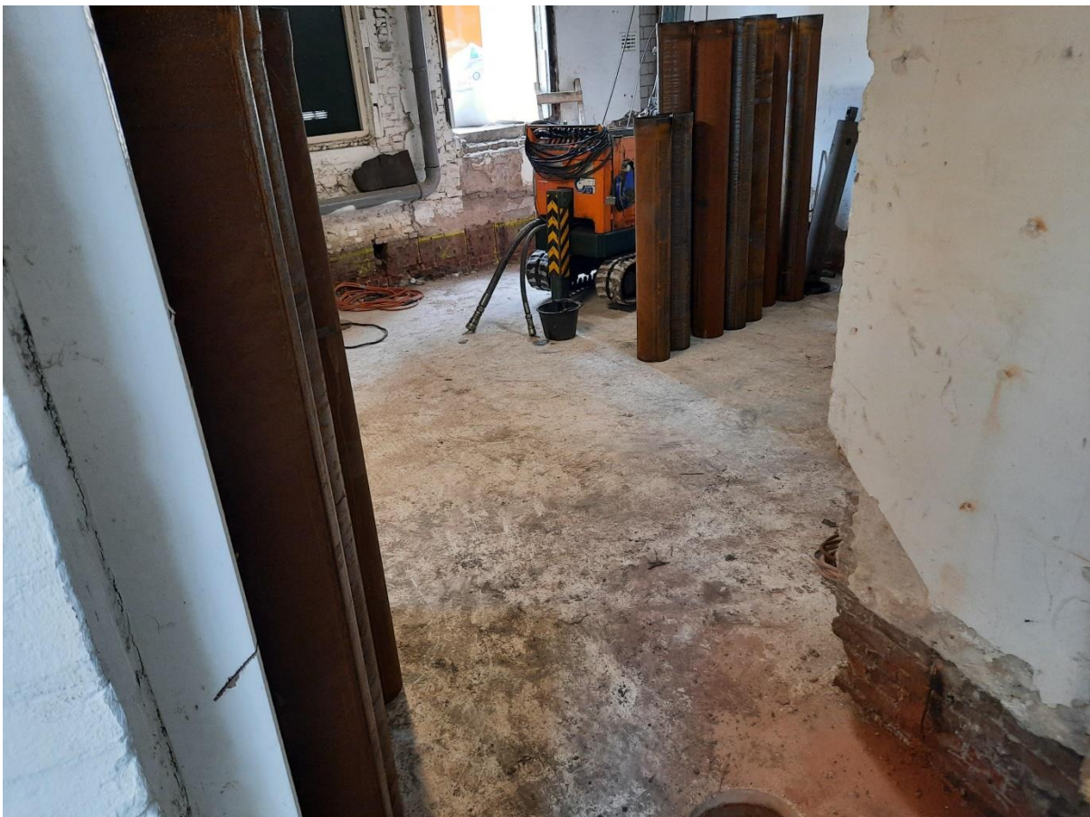
Verontreiniging afgedekt met betonnen (werk)vloer
