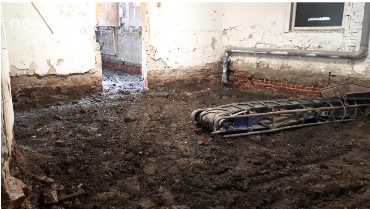
Situatie voorafgaand aan storten betonvloer
