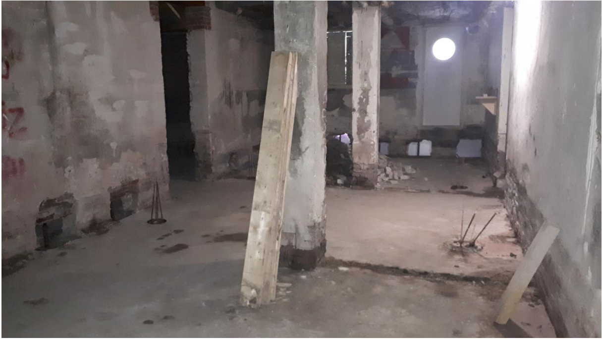
Verontreiniging afgedekt met betonnen (werk)vloer
