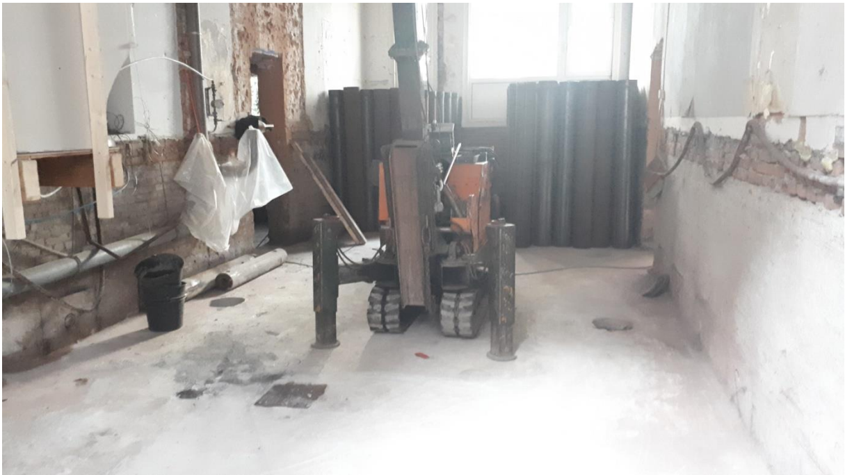
Verontreiniging afgedekt met betonnen (werk)vloer
