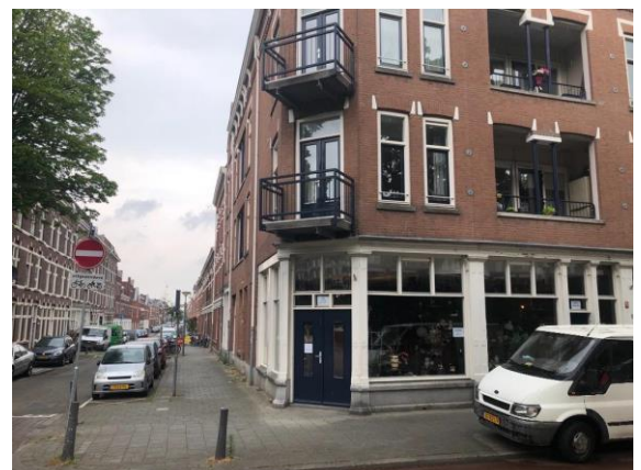
Foto 2: fase A, hoek Aegidiusstraat / Oostzeedijk Beneden
