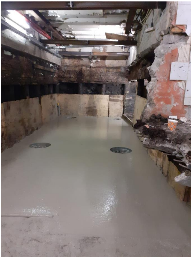
Einde sanering; betonnen (werk)vloer gestort
