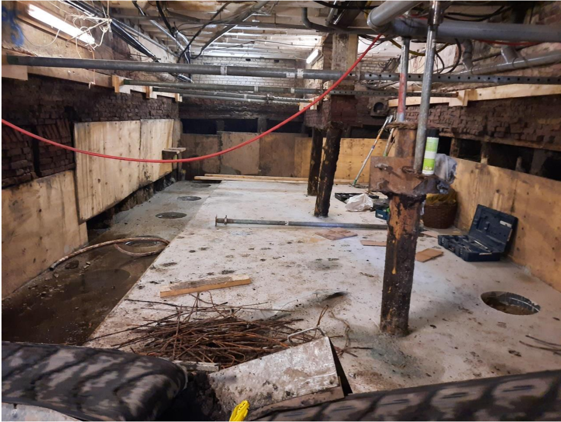
Einde sanering; betonnen (werk)vloer gestort
