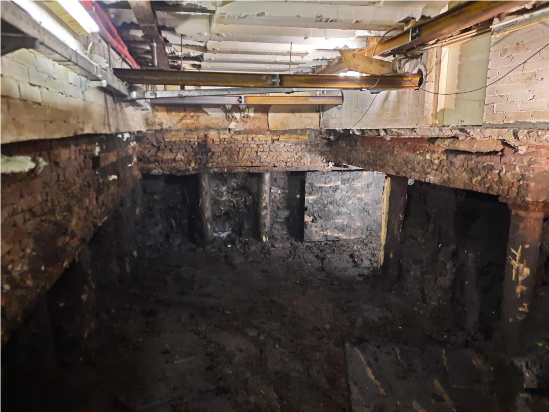
Ontgraving tot 'schone' veenlaag
