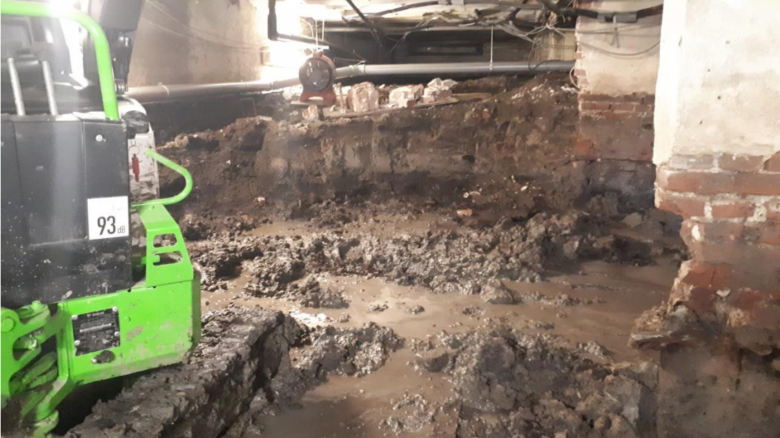
Ontgraven en afvoeren verontreinigde grond
