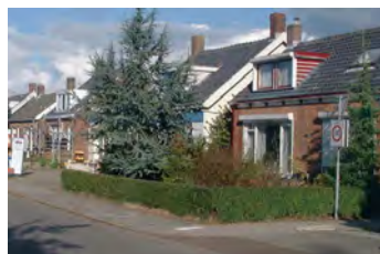
Toevoegingen en verandering van gevelindeling verstoren samenhang.
