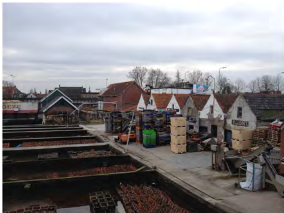
Gebouwensembles aan de noordzijde van put 14-a (tegen het parkeerterrein van de jachthaven)
