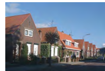
Afwisseling van kop- en langsegevels zorgen voor een aangenaam gevelbeeld.
