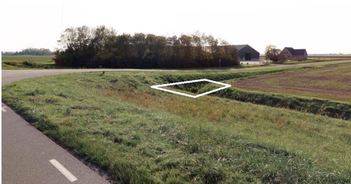
Figuur 4: Locatie waar werkzaamheden plaats vinden gezien vanaf de Geldersedijk.
