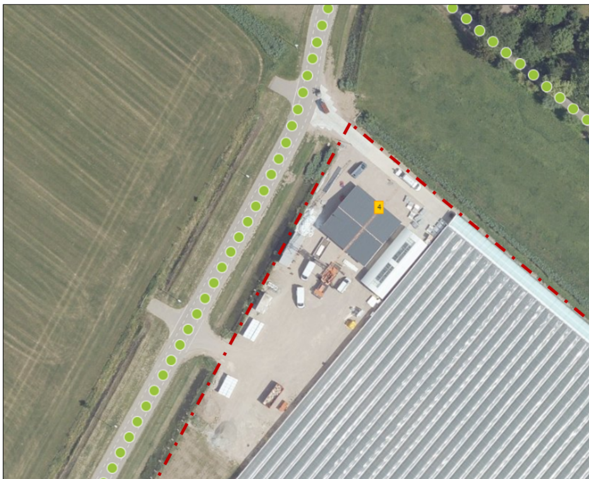
Luchtfoto huidige situatie met de ligging van het ondersteunend bedrijfsgebouw en de twee overkluizingen van de B-watergang in de vorm van duikers langs de Clivia
