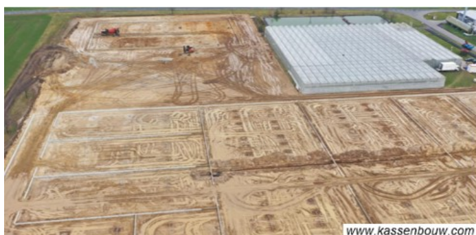
Voorbeeld bouwrijp maken voor kassenbouw
