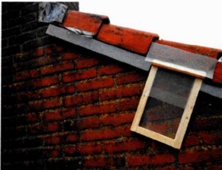
Figuur 1: Detail exclusion flap met dichtzetten gevelpan in combinatie met gootborstels en latten.
