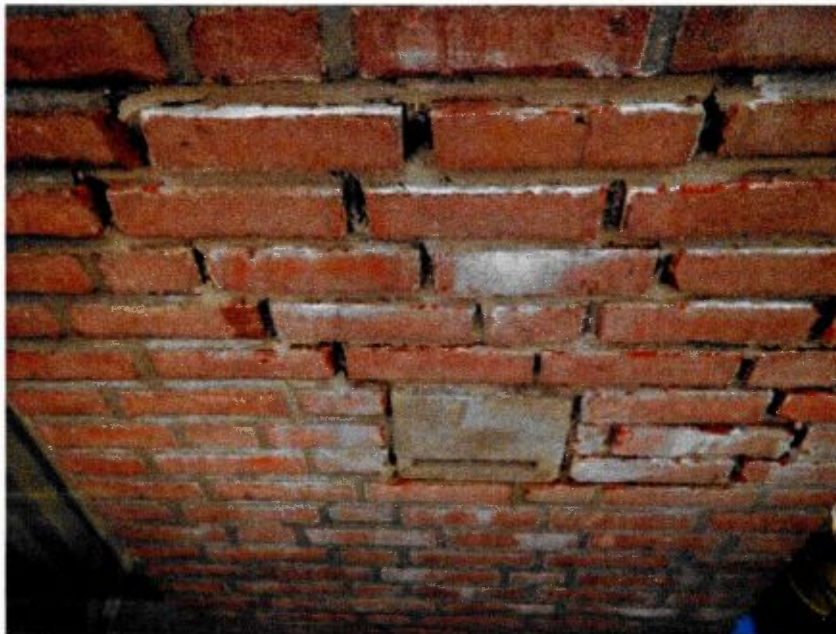
Figuur 7 Details geschakelde vleemmuur-inbouwkast. Ingebouwde IB VL 01 waarvan alleen nog maar de inligopening te zien is. Rechts van de inligopening is de IB VL 02 achter de stenen ingebouwd.
