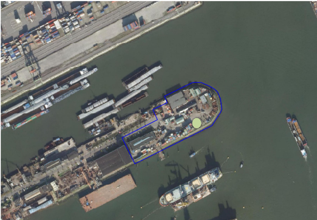
figuur 1: locatie opslag gasflessen
