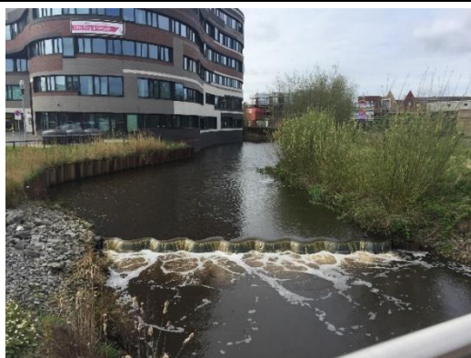
Figuur 6. Stuw Oostelijke Havendijk
