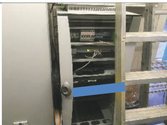
Voap en switch plaatsen
