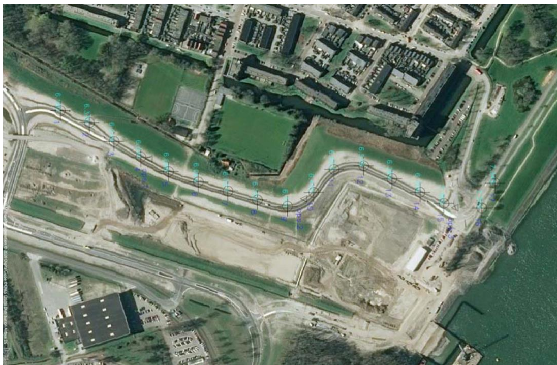
Locatie meetpunten maaiveld waterkering Rozenburg
